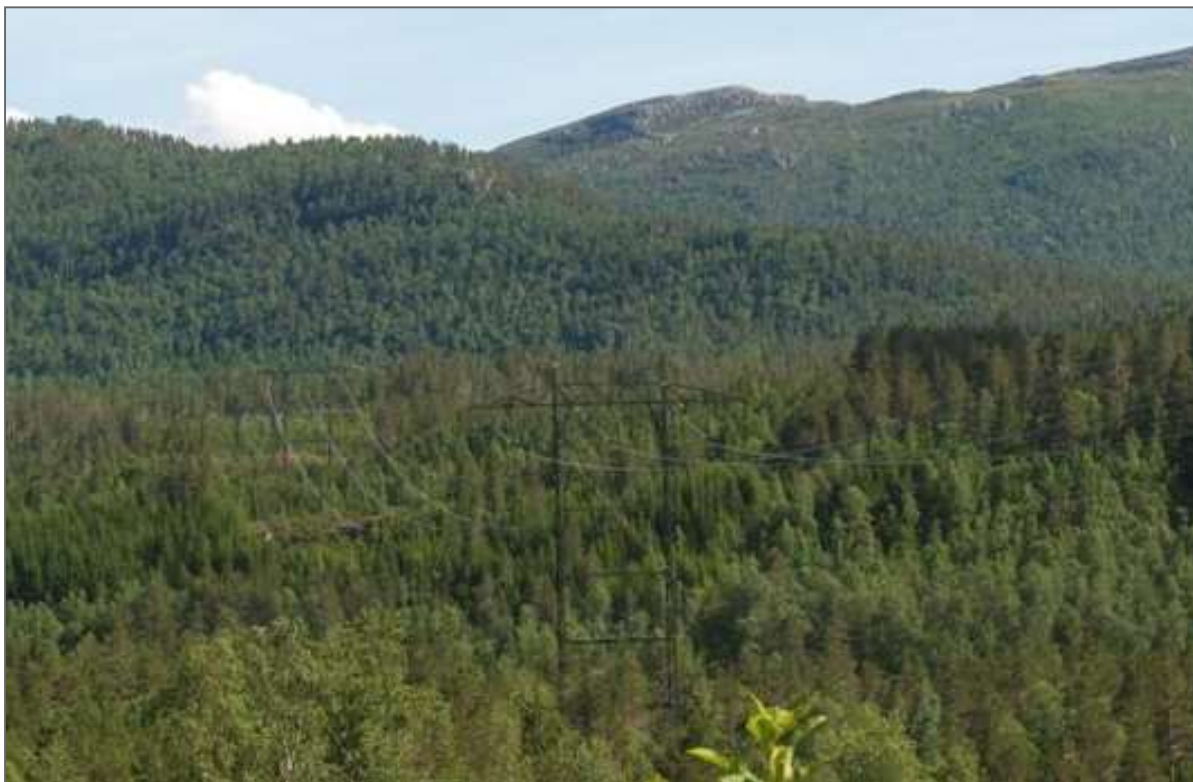
Figur 10-1. Bilde av kamuflert kraftledning. Mastene er grønnmalt, linene er mattede, og isolatorene er av kompositt i stedet for av glass som er vanligst å benytte. Kilde: Statnett.
