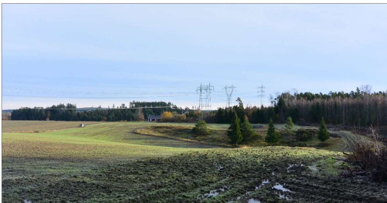
Figur 9-6: Eksisterende firedoble trasé gjennom Maugestad-området. Traséen som skal rives og erstattes er nummer to fra høyre.
