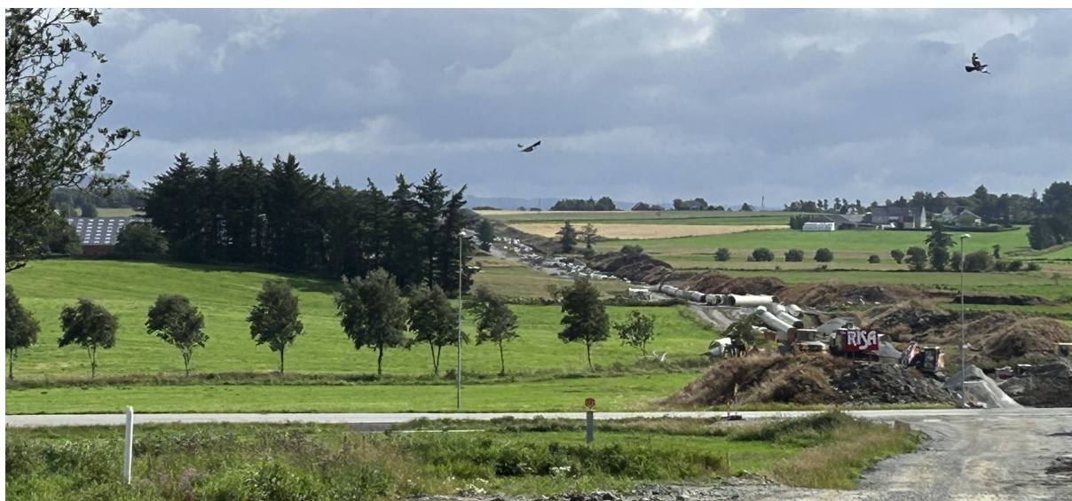
Figur 13 Fra arbeidet med ny hovedvannledning ved Heigreveien sett mot sør.
