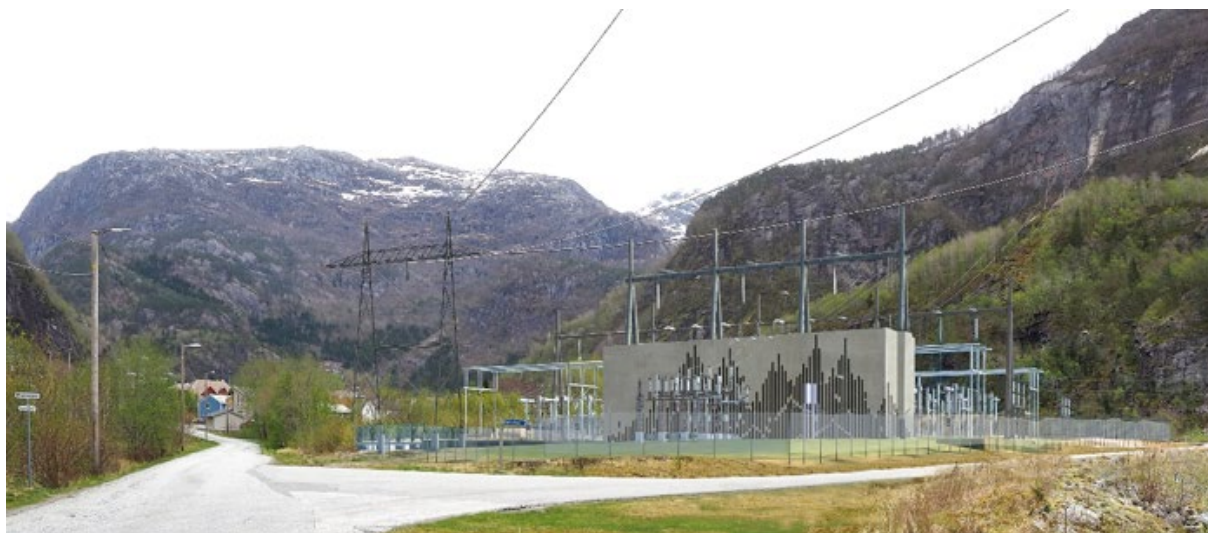
Figur 6 Trafosjakt med fasadetiltak, visualisert av Multiconsult.
