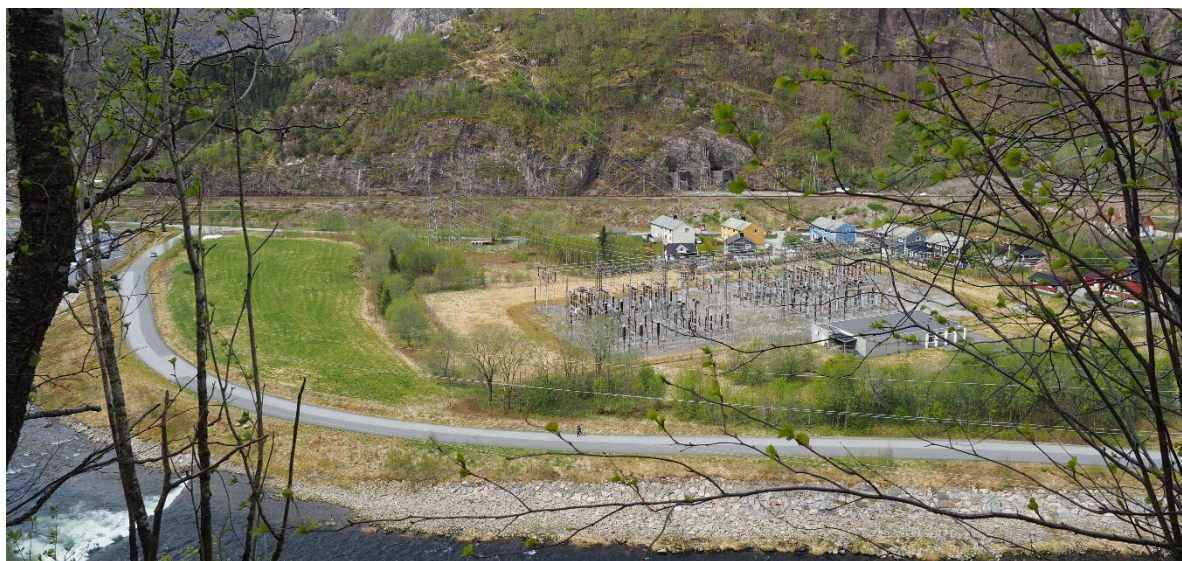
Figur 2 Bildet viser tomt for ny stasjon (inkl. grøntareal til venstre) og dagens anlegg som skal rives.
