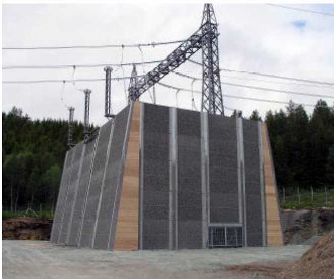
Figur 8:Eksempel på innbygging av reaktorer
