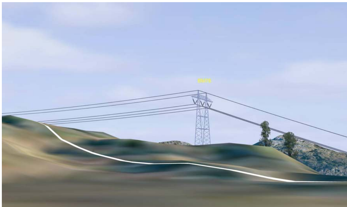
Figur 3. Figuren viser konsesjonssøkt alternativ sett fra Snipa. Mast 78 vil dominerende utsynet mot øst.
