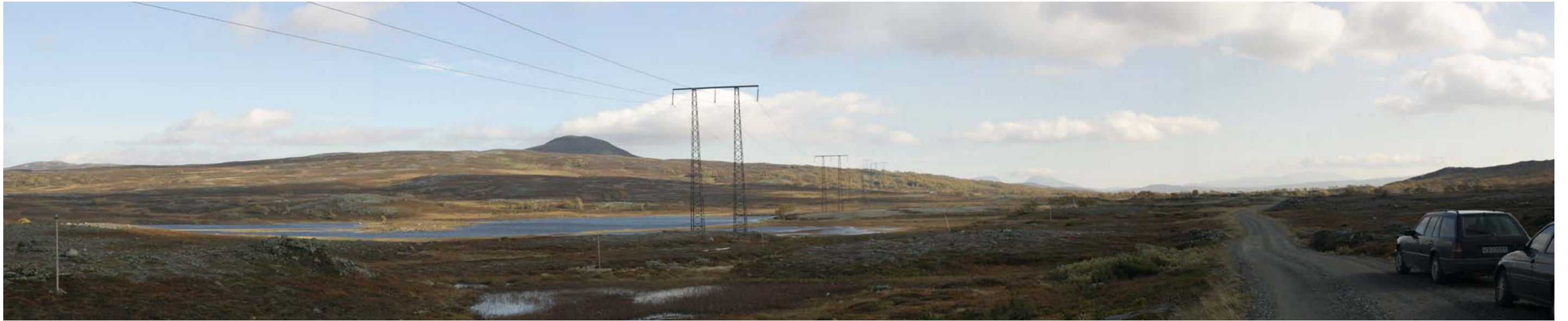
Eksisterende 300 kV-ledning fra Kroessdurrie mot øst. Foto Trond Simensen, SWECO Grøner.
