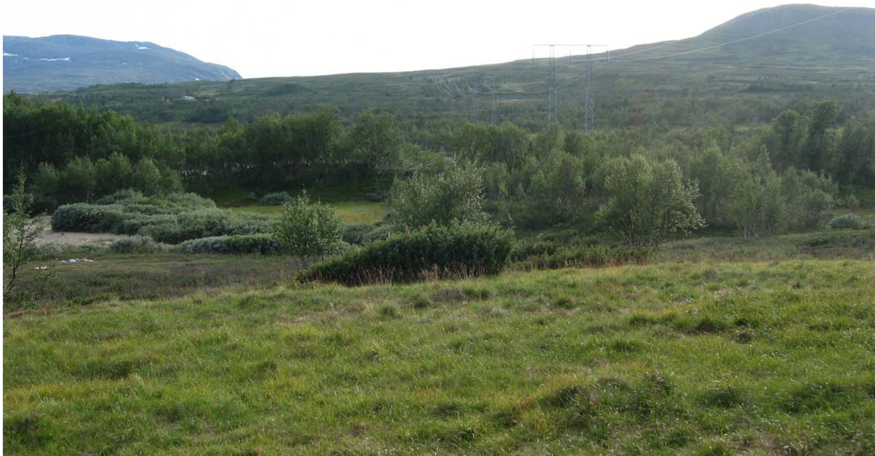
Eksisterende 300 kV-ledning fra Sankåvollen mot Gardkleppen. Foto: Magne Maurset, Statnett.
