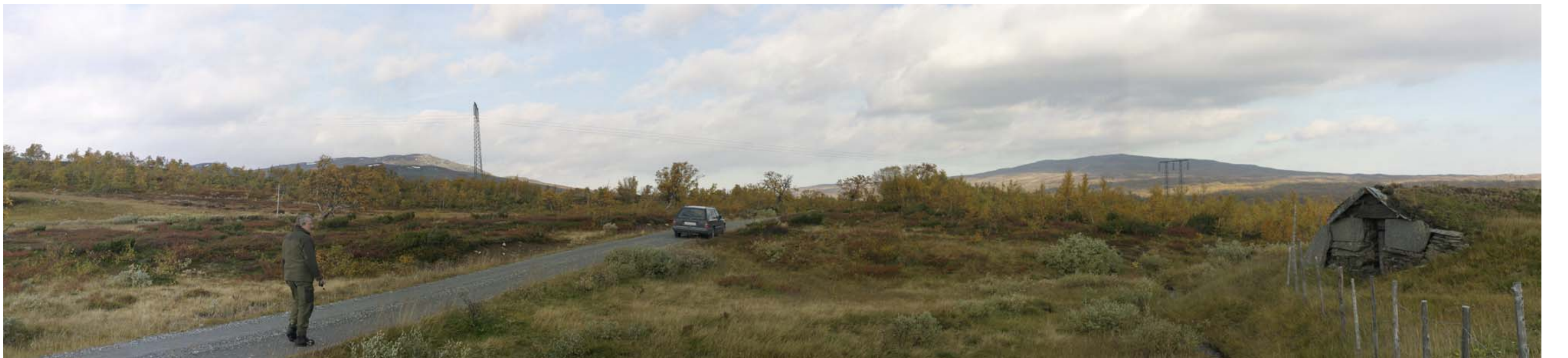
Eksisterende 300 kV-ledning fra gardkleppvollen mot nord. Foto: Trond Simensen
