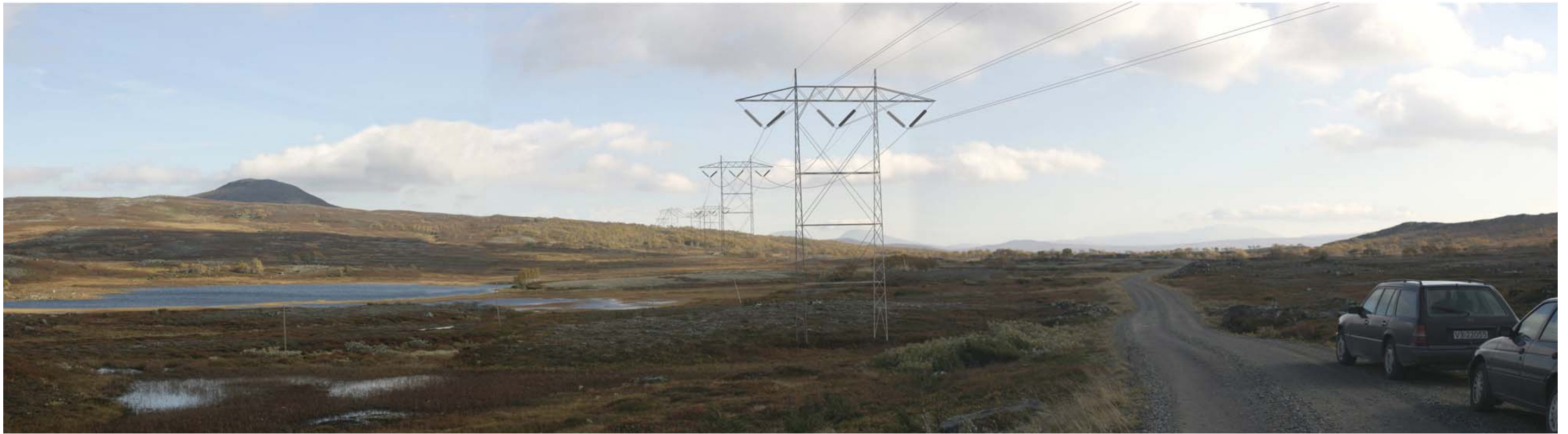
Visualisering fra Kroessdurrie mot øst. Alternativ 1.0 med innvendig bardunerte master. Foto og visualisering: Trond Simensen, SWECO Grøner
