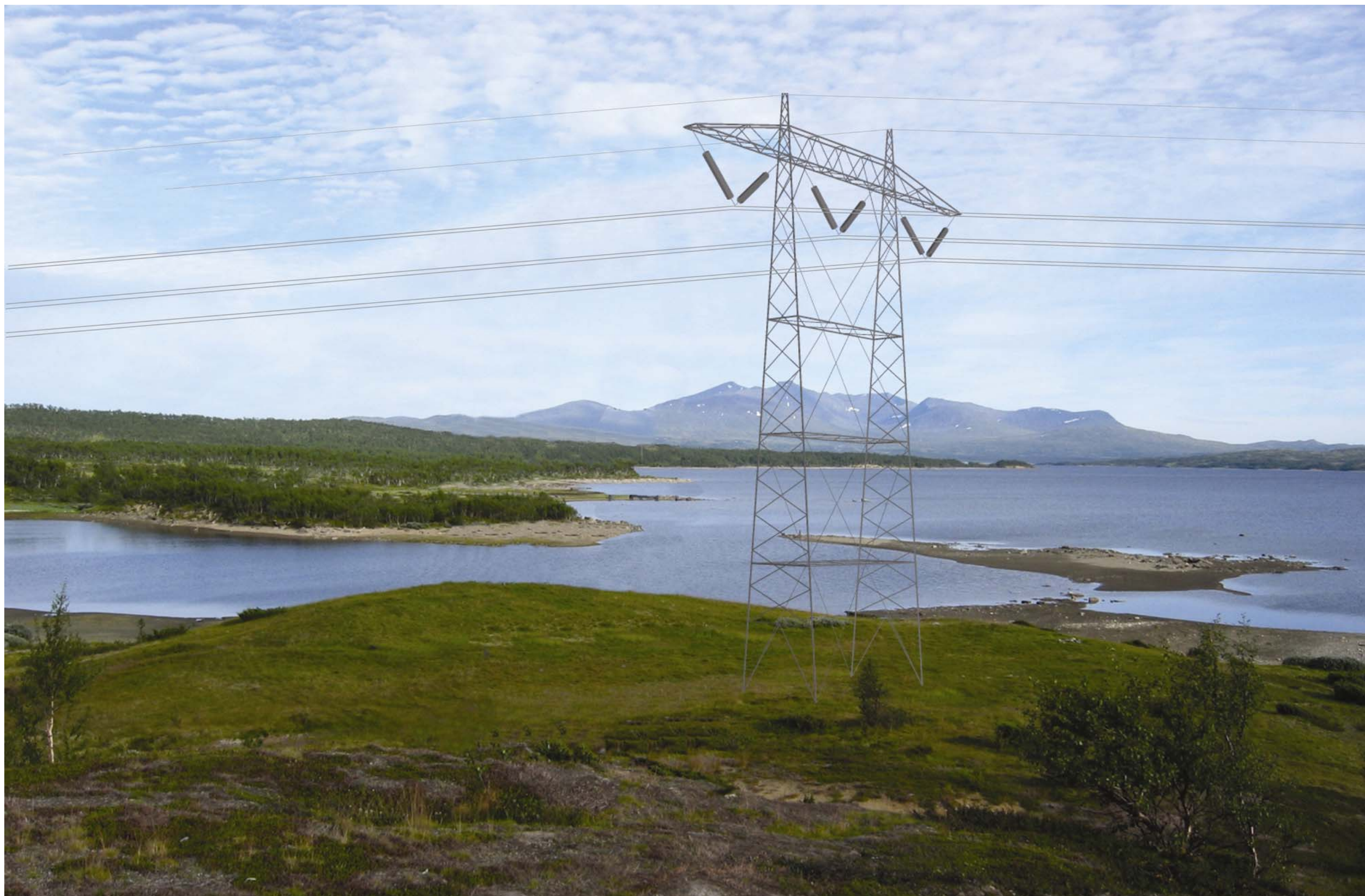
Visualisering fra Sankåvollen mot Sylane. Alternativ 1.0 med innvendig bardunert mast. Foto: Magne Maurset, Statnett. Visualisering: Trond Simensen, SWECO Grøner
