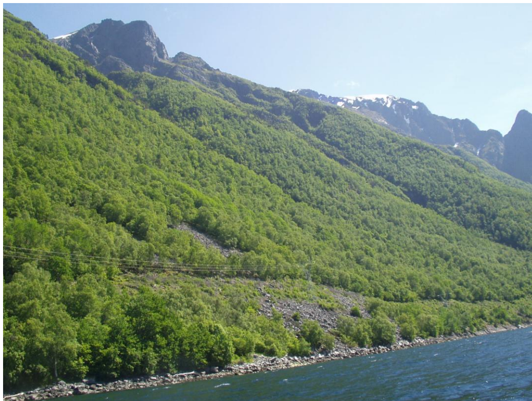
Figur 4.1 Eksisterende 132 kV linje gjennom Gjevenesstranda NR. Foto: Helge Fjeldstad.
