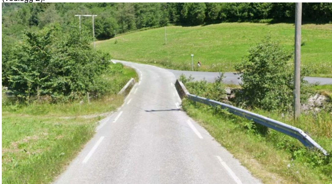
Figur 11: Eksisterende bro i Ovrisdalen
