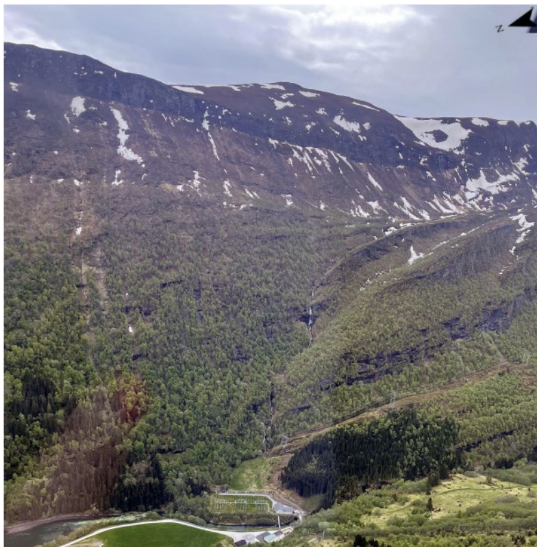
Figur 19: Oversiktsbilde av dagens stasjonsområde (bildet er tatt mot sørøst). Lambafossen fra sør ned mot stasjonen. Fyrjaeggi (1137 moh.) ligger sørøst for dagens stasjon, rett frem på bildet. Rislågnipa (1016 moh.) ligger rett utenfor bildet mot nord. Bildet viser flere nye skredbaner ned mot stasjonen fra fjellsiden i øst, samt raviner i sør. Kilde: NGI, 2023.
