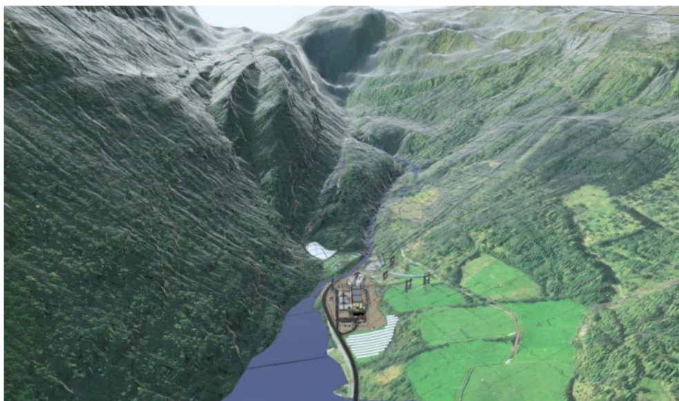
Figur 38: Modellen viser oversikt over området hvor ny transformatorstasjon er lokalisert. Sett mot sørvest. Kilde: Sweco, 2022.
