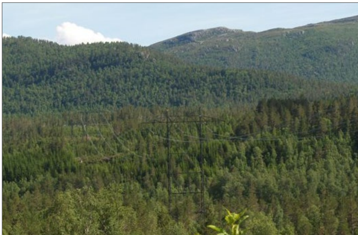
Figur 16 Bilde av kamouflert kraftledning. Linene er mattet, og isolatorene er av kompositt i stedet for av glass som er vanligst å benytte.
