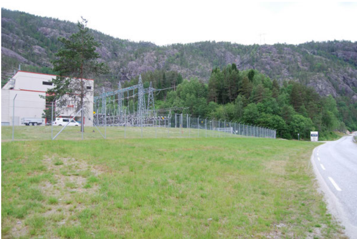
Figur 3. Eksisterende Leirdøla transformatorstasjon.
