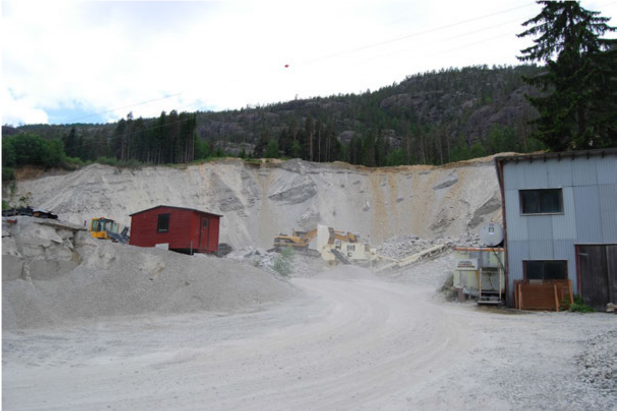
Figur 10. Eksisterende massetak som viser lagdelingen i massene. Det er grunn til å anta at samme type lagdeling befinner seg i grusryggen mellom dagens stasjonsanlegg og Reiarsmoen massetak.
