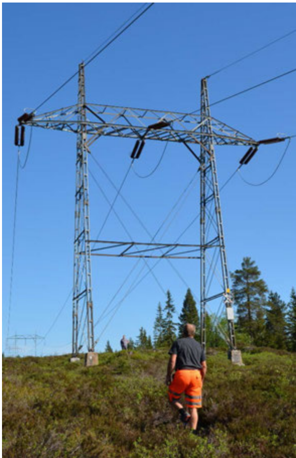
Figur 7. Bilde av Statnetts standard forankringsmast.
