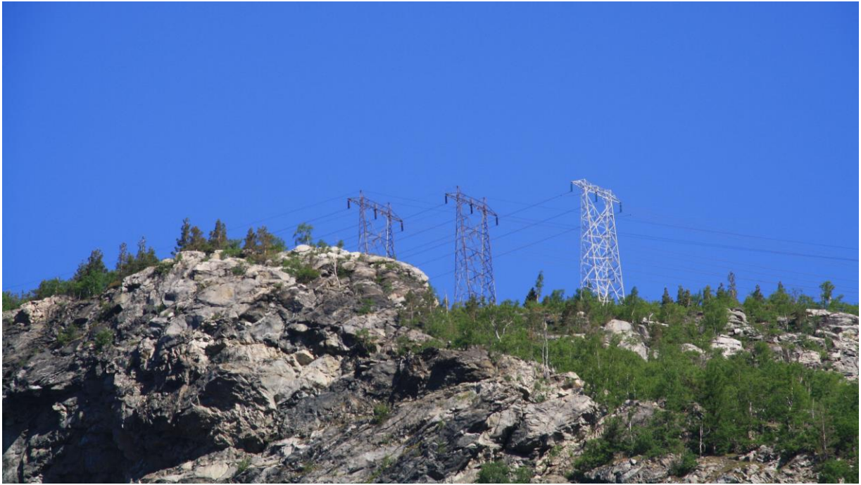
Figur 3-37. 132 kV master (Fortun -Øvre Årdal). Aluminiummasten til høyre er mer fremtredende i landskapet enn de to stålmastene til venstre, spesielt med blå himmel i bakgrunnen. Foto: Statnett.
