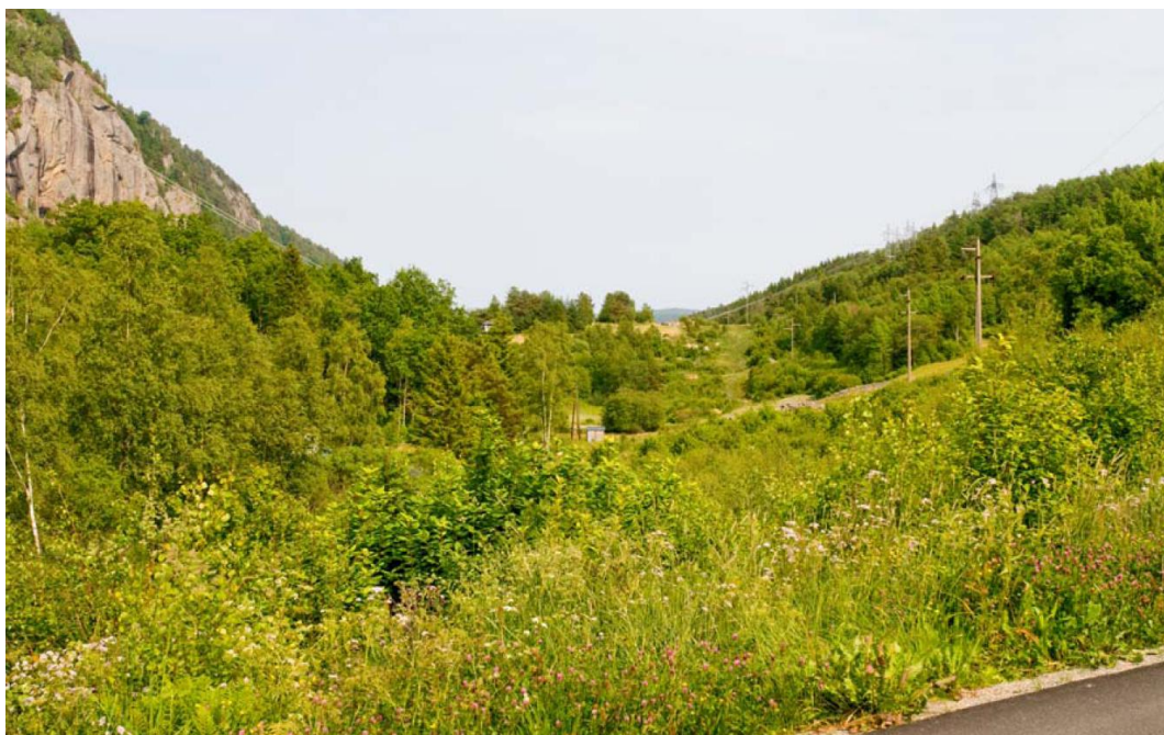
Figur 5.1.2 – Dagens situasjon sett vestfra, med betongmastledningen som et iøynefallende element
