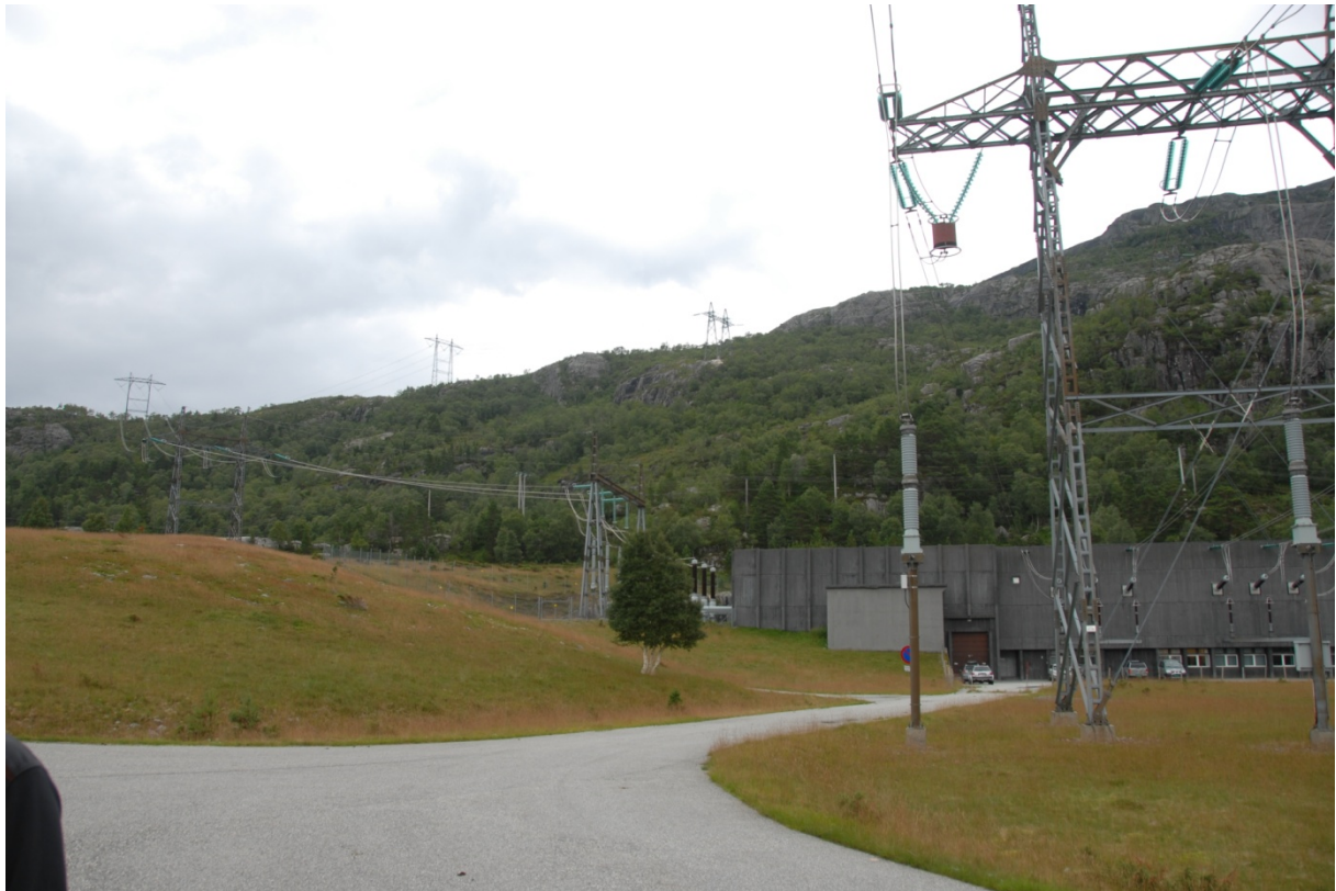
Figur 15. Eksisterende Saurdal stasjon sett mot øst.
