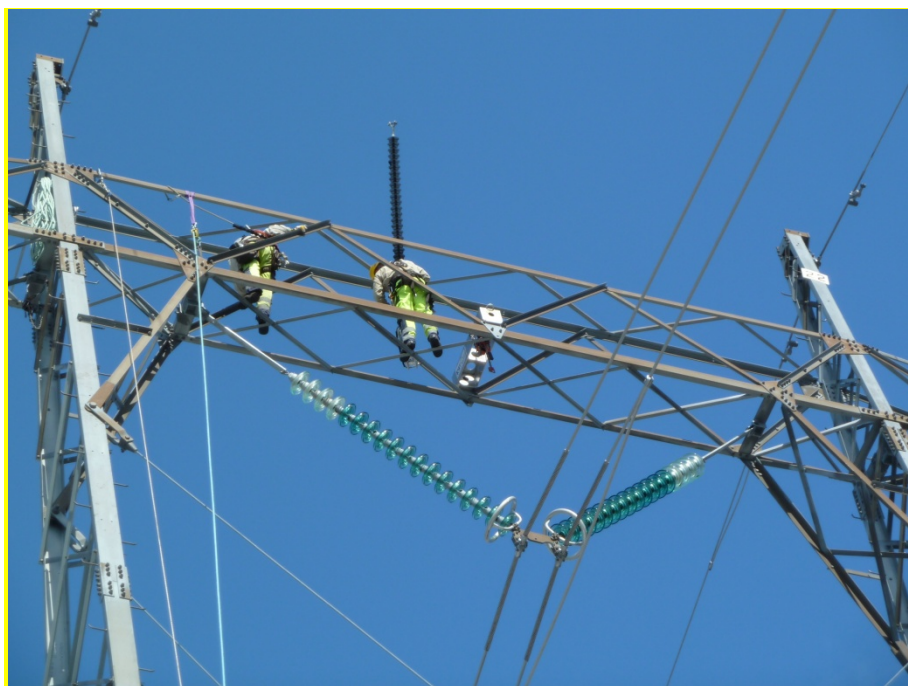
Figur 2. Eksempel på mast med de to typene isolatorskåler, klart glass og grønt glass.
