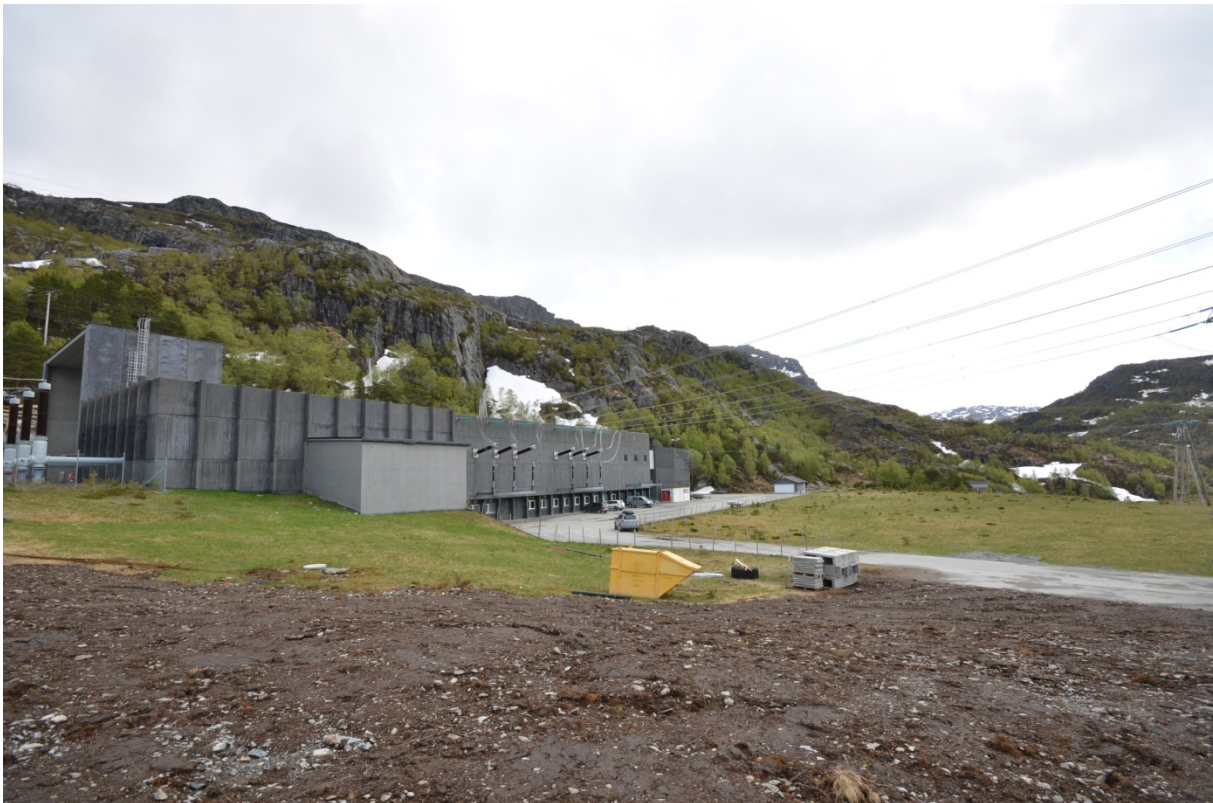
Figur 14. Eksisterende Saurdal stasjon sett mot sørøst.
