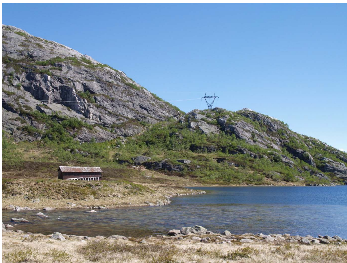
Figur 18. Eksisterende ledning forbi Grauthellervatnet. Fra Grautheller vil de visuelle virkningene bli tilnærmet som før fordi omsøkt ledning planlegges i dagens trasé frem til Duge koblingsanlegg. Foto: Statnett
