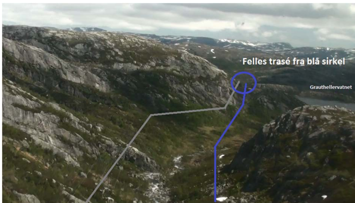
Figur 17. Ved Grauthellervatnet. Frem til vannet går omsøkt trasé i et dalsøkk, tilnærmet parallelt med eksisterende ledning (illustrert med grå strek) før den går inn i dagens trasé. Foto: Statnett
