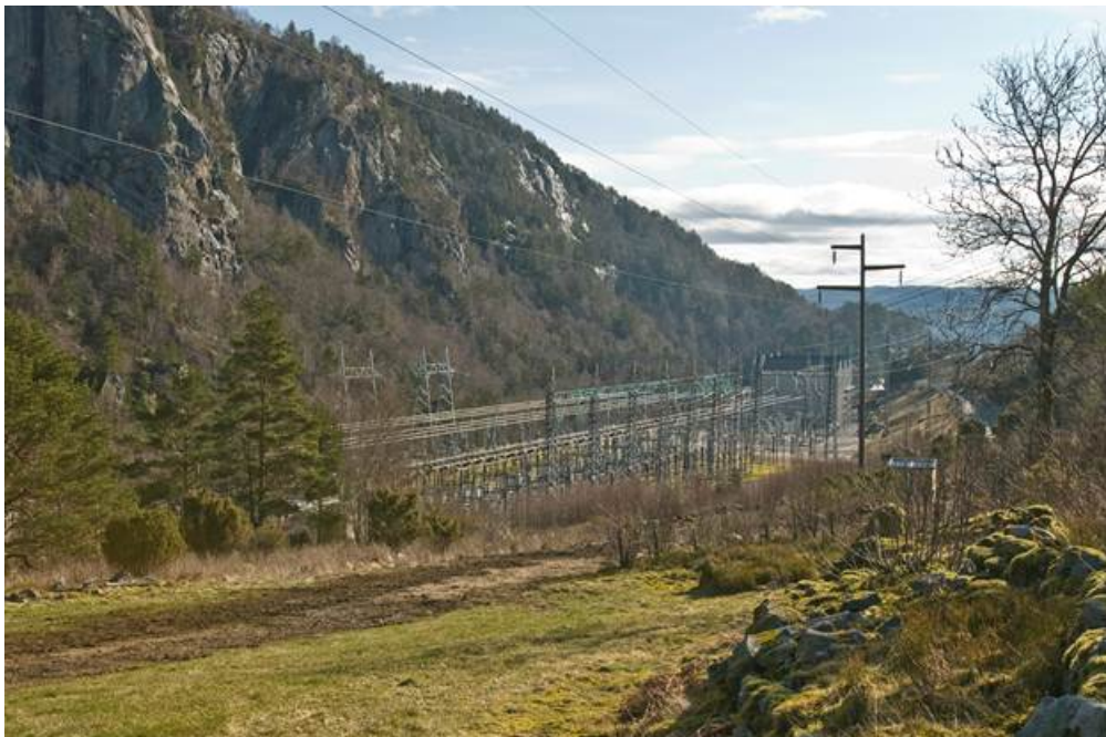
Figur 6. Eksisterende 300 kV anlegg som kan rives når Kvinesdal stasjon er etablert.
