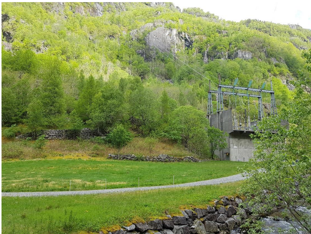
Figur 1. Eksisterende Hylen koblingsstasjon. Flomskredmuren vil bli anlagt fra bygningens bakre venstre hjørne og opp i skråningen bak stasjonen.
