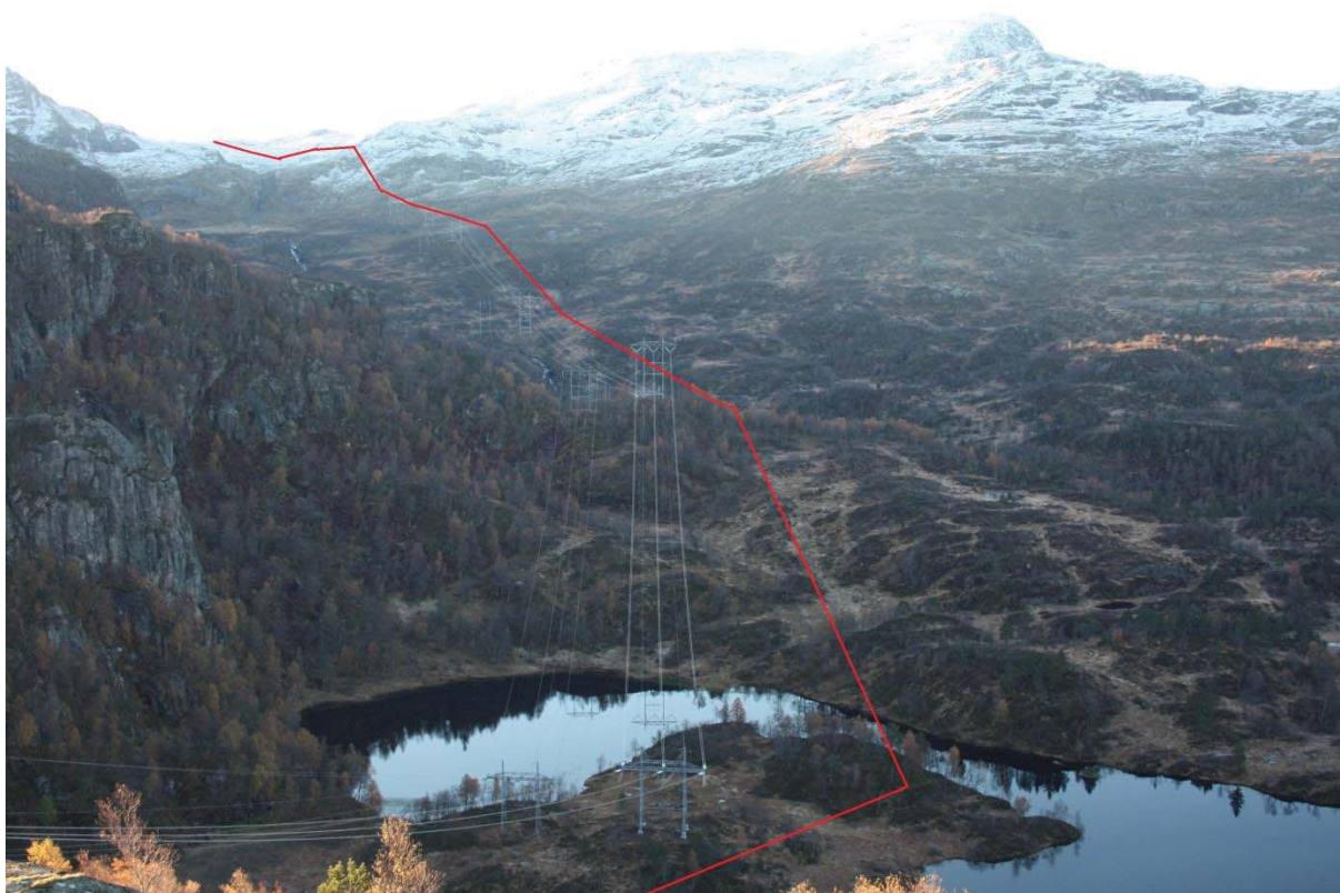
Figur 8. Vatnedalsvatnet i Sauda kommune. Ny 420 kV-ledning Sauda-Hylen blir liggende på vestsiden av eksisterende ledninger, som antydnet med rød strek. Ledningen lengst til venstre rives.
