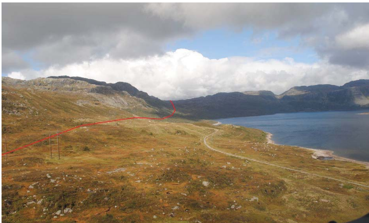
Figur 12. Sandsavatnet sett mot nord. 300 kV-ledningen Hylen-Førre ligger her på vestsiden av eksisterende 300(420) kV-ledning Lyse-Saurdal. På denne strekningen vil den nye ledningen bli bygget på vestsiden av ledningen Lyse-Saurdal, etter at ledningen Hylen-Førre først er revet.
