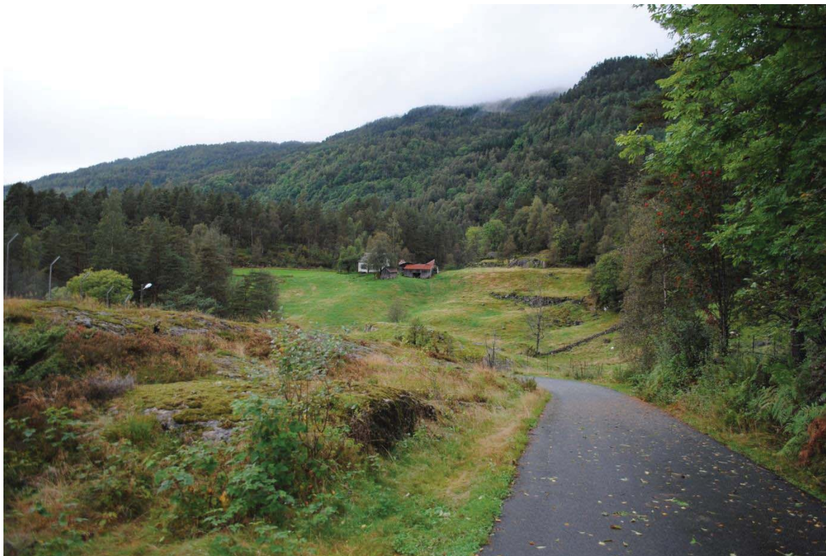
Figur 20. Aktuelt område for nytt 420 kV-anlegg ved Sauda transformatorstasjon.
