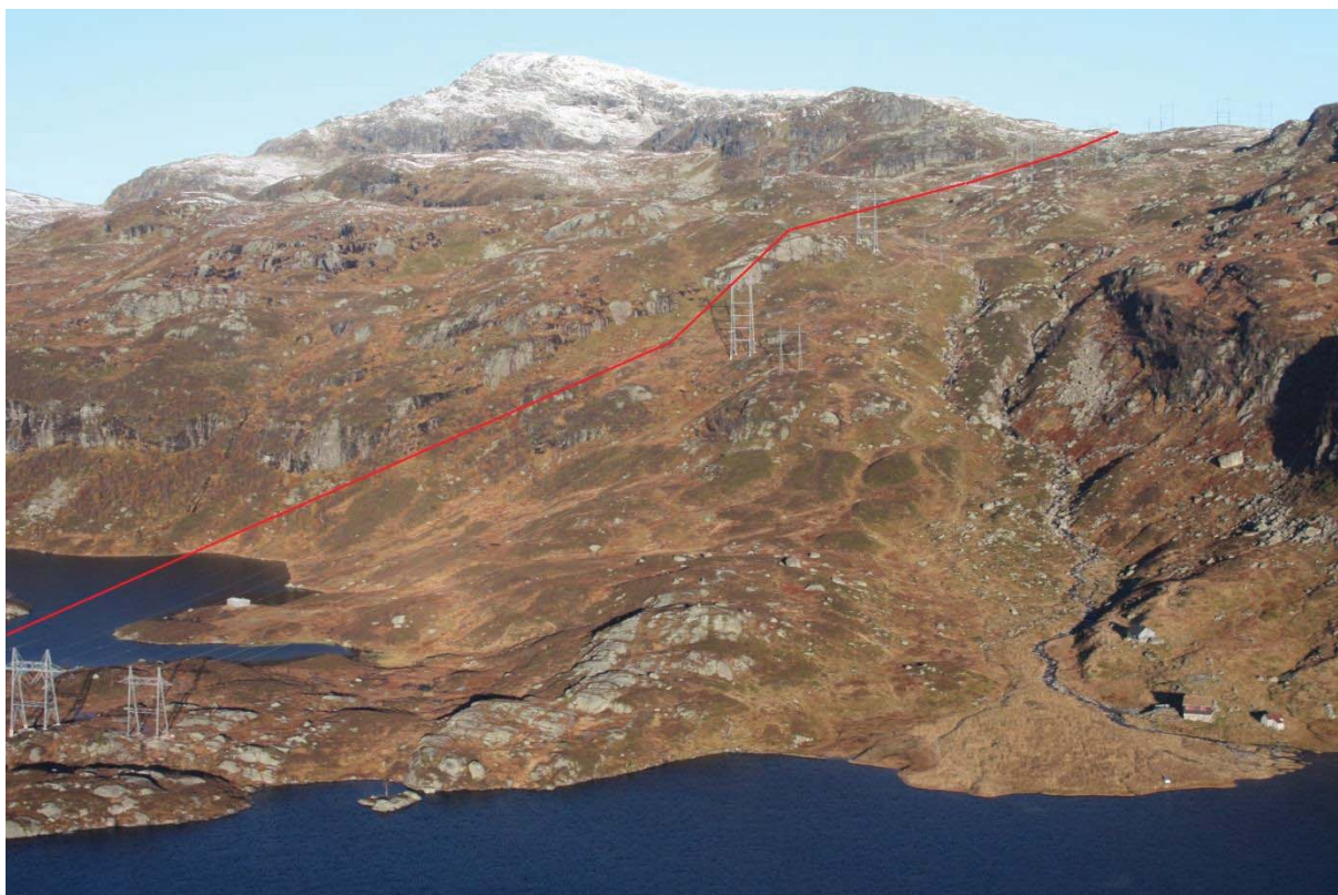
Figur 9. Tengedalsstølen, helt til høyre i bildet, sett mot nord. Ny ledning vil komme på bortsiden av eksisterende ledninger, sett fra stølen. Den nærmeste ledningen rives.
