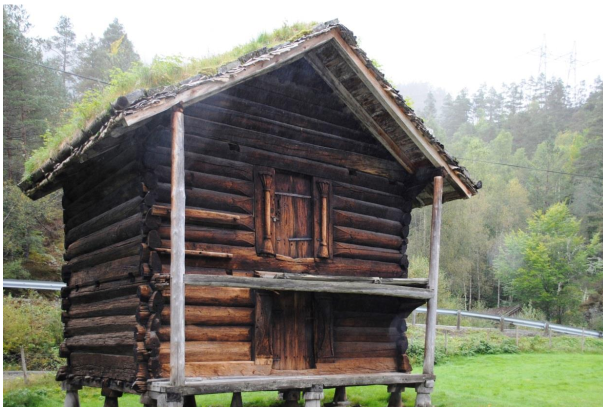
Figur 15. Stabbur, Rogalands eldste bygning fra 1281. Foto: Inge Lindblom
