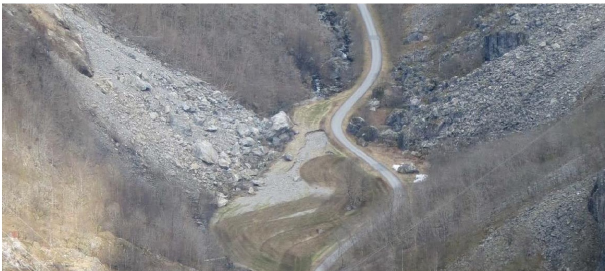
Figur 4. Oversiktsbilde av jorde øst for stasjonstaomta. Materiallager planlegges i nedre del av utsnittet. Erosjonsskader fra Hylsåa i fremkant av rasfoten.
