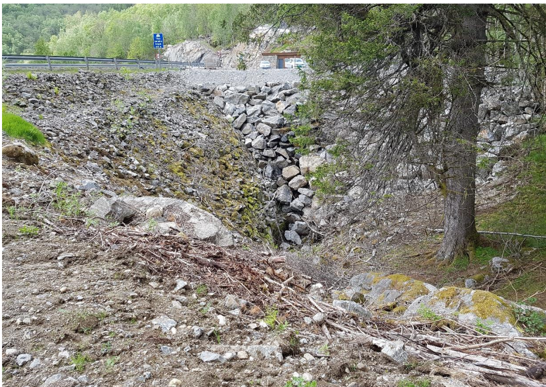
Figur 3. Omsøkt deponiareal ved Våge sett fra øst. Riksveg 13 ligger på fyllingen til venstre.
