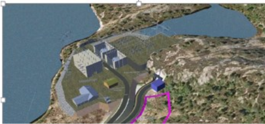
Figur 3: Fjotland transformatorstasjon sett fra sør-øst.
