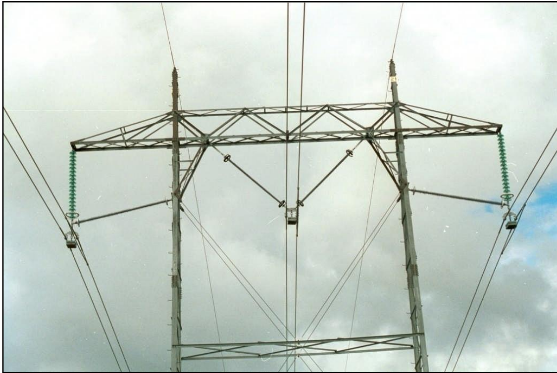
Figur 5.6.3. Bildet viser en mast med isolatorer i en såkalt V-kjede i midten og L-kjeder på sidene. Et mindre antall master på strekningen kan få slike isolatorer. Dette gjøres i så fall for å hindre at linene svinger sideveis, med fare for overslag mot mastebeina eller barduner.
