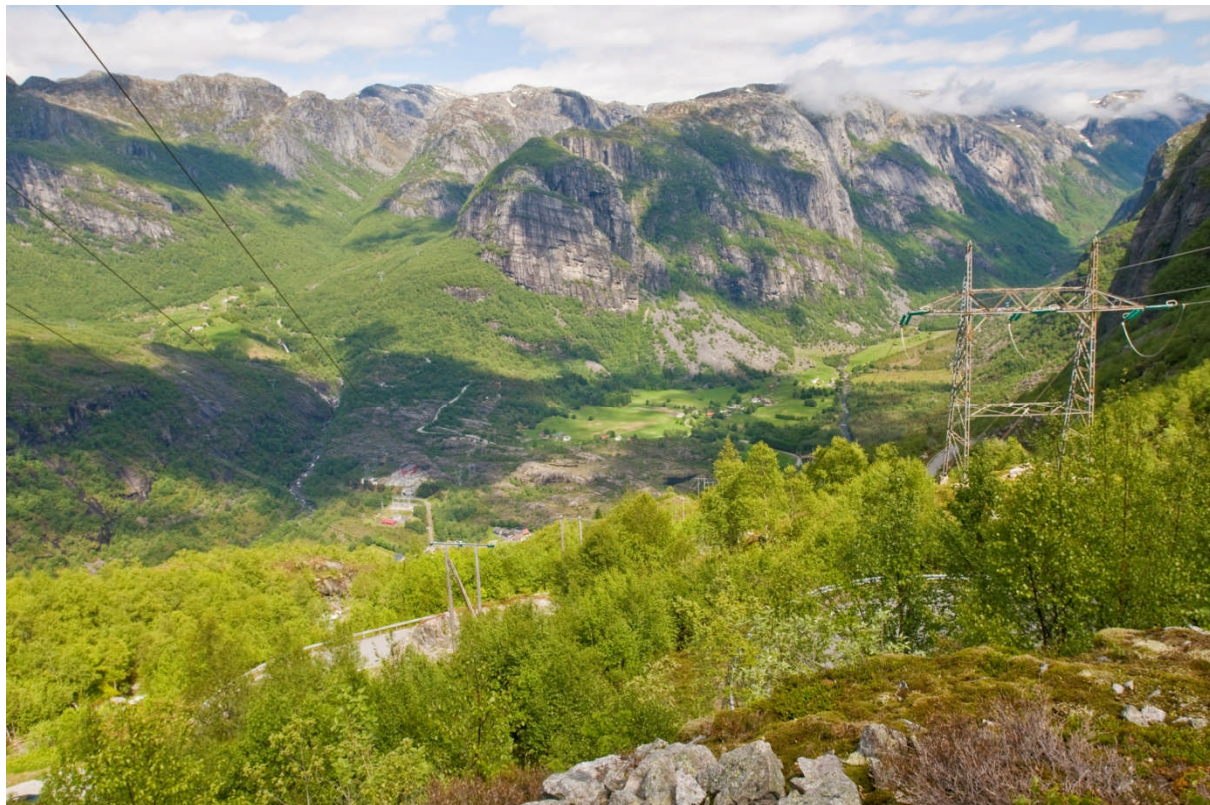
Figur 25. Eksisterende Lyse transformatorstasjon er i dag godt synlig fra Øygardsstølen.
