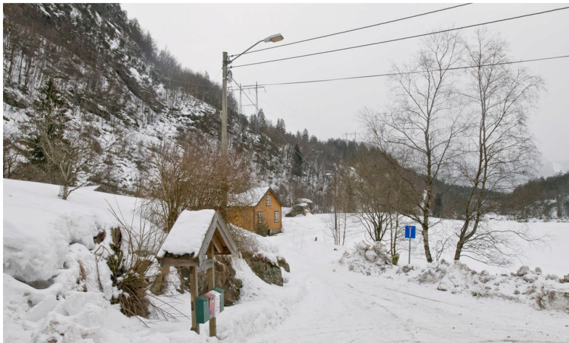
Figur 23. Dagens situasjon ved Seland, hvor 300 kV ledningen går kloss inntil bebyggelse.
