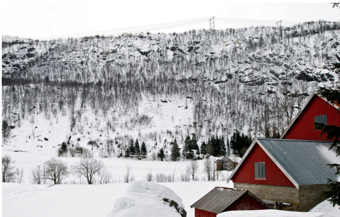
Figur 24. Eksisterende 300 kV ledning danner en silhuett langs åsryggen øst for Ousdal. Nytt alternativ 1.0V vil gå nærmere bebyggelsen enn dagens ledning.
