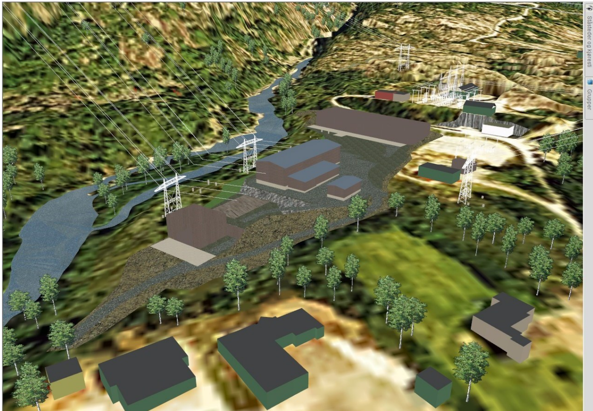
Figur 9 - Utklipp fra Statnett sin VR-modell for nytt GIS-anlegg i Lysebotn. Eksisterende koblingsanlegg ses i bakgrunnen. Nytt anlegg vil bli innebygget, som vist i figuren.
