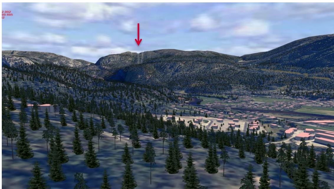
Figur 15. Utsnitt av VR-modell sett fra Finså, Tonstad i forgrunnen. Pilen markerer innføringen fra Solhom til Ertsmyra (ledningen til høyre). Ledningen er lagt parallelt med omsøkt 420 kV ledning til Lysebotn (ledningen til venstre).
