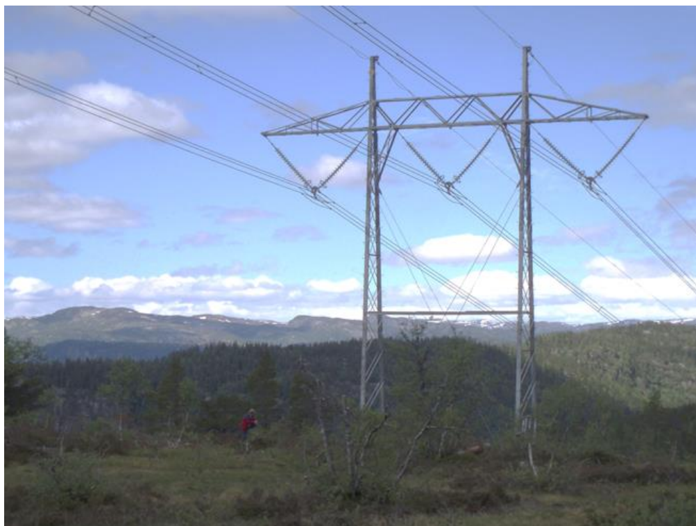
Figur 5. Bilde av 420 kV bæremast med triplex linetverrsnitt
