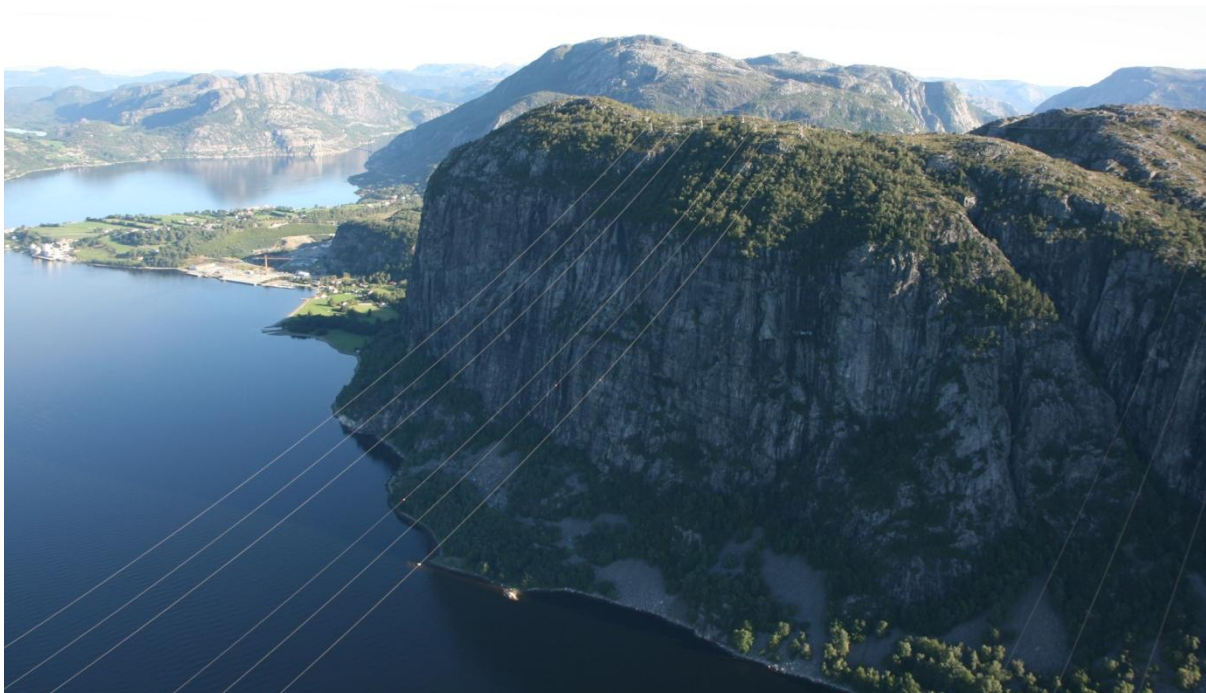
Figur 4.8. Eksisterende 132 kV fjordspenn over Høgsfjorden. Bildet er tatt fra helikopter inn mot Uburen. Det nordligste (lengst til venstre i bildet) av disse tre spennene vil rives og erstattes med ny 420 kV forbindelse.
