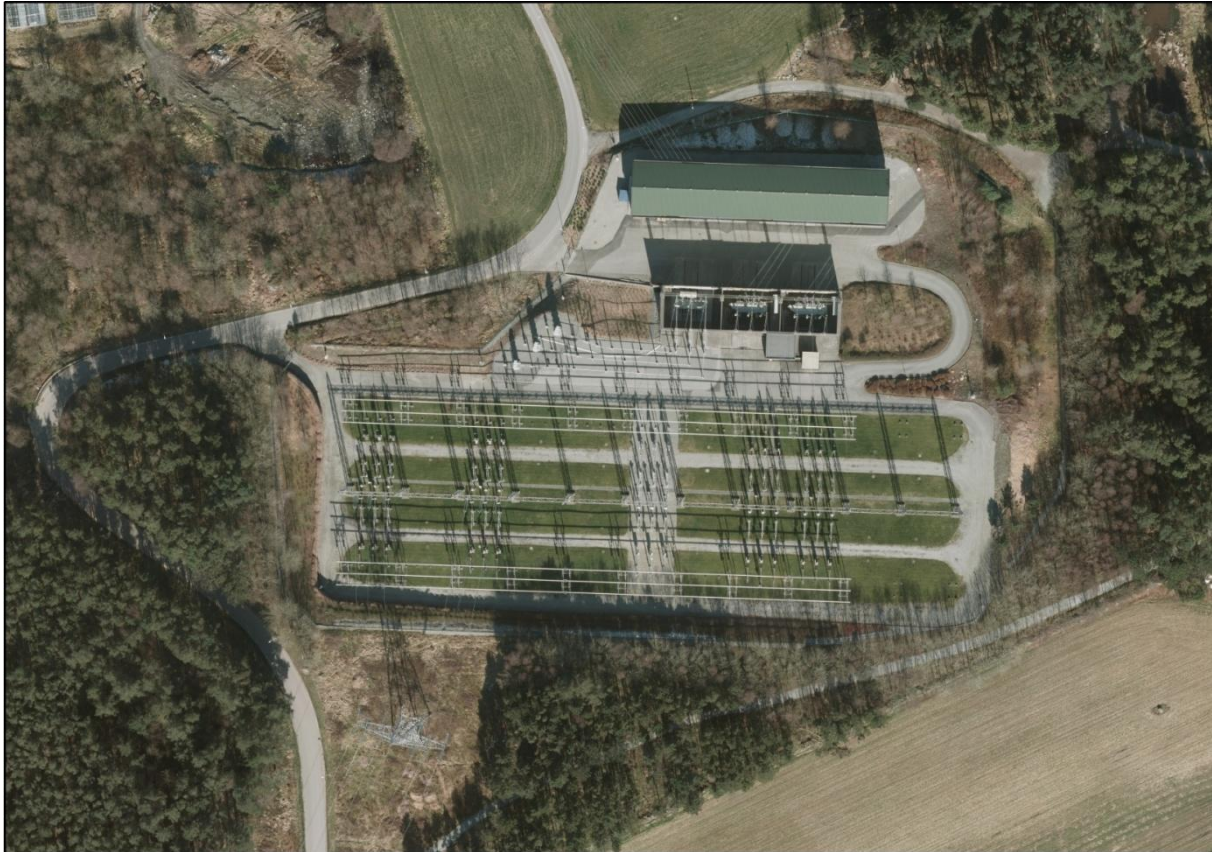
Figur 4.22. Eksisterende Stølaheia transformatorstasjon.
