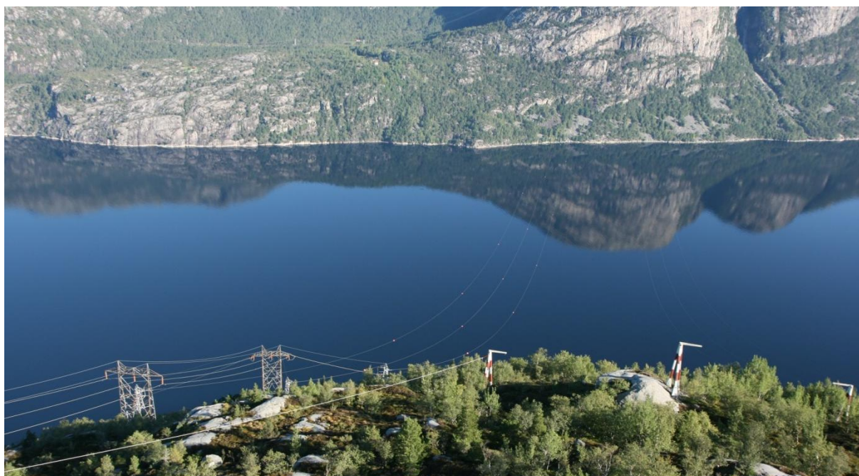
Figur 4.5. Eksisterende fjordspenn Sjøhadle – Mulen. Bildet tatt fra Mulen. Den vestligste (til venstre i bildet) kryssingen er 132 kV Lysebotn – Tronsholen 2. Denne vil fjernes og erstattes med ny 420 kV.
