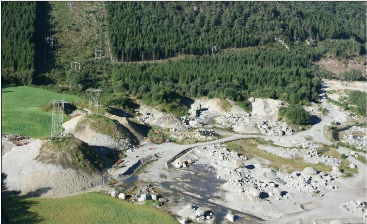
Figur 31 Dagens 132 kV-ledninger over masseuttaket på Fossanmoen. Den ene sandhaugen vil bli fri for master når ledningen Lyse–Tronholen 2 rives. (Kilde: Konesjonssøknad av mai 2013)
