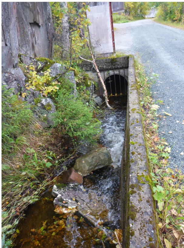
Figur 21. Samlet vann fra to bekkeløp ledes inn i røret og inn mot den store vanntunnelen.
