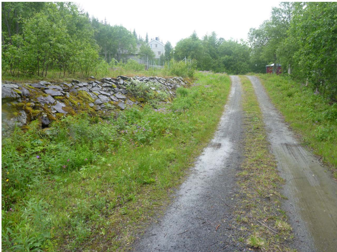
Figur 8. Restene av muren til den gamle dammen oppe ved Vemorktoppen vises til venstre i bildet. Damvokterboligen i bakgrunnen. Bildet er tatt fra ny plassering av port inn til koblingsanlegget.
