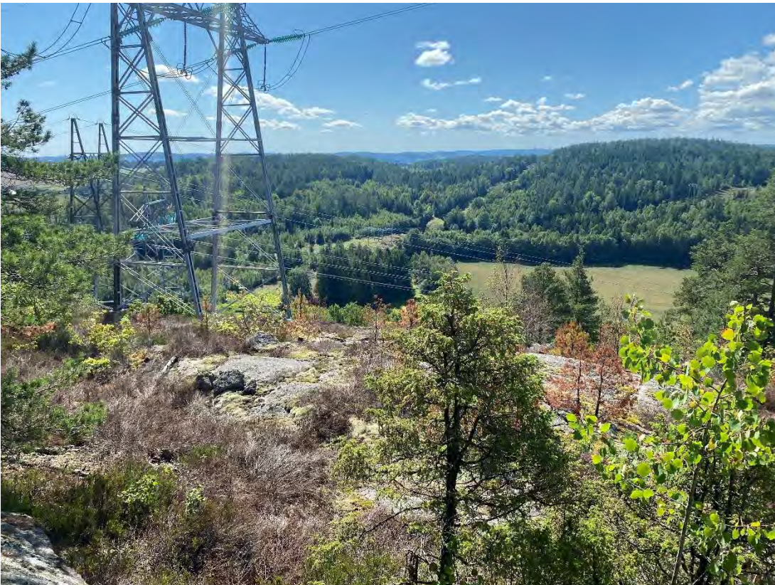
Figur 2-31. Foto fra søndre del av Undrumsdalsåsen mot Gulliåsen i bakkant. Bildet er tatt mot sør med planlagt område for transformatorstasjon midt i bildet i bakgrunnen. Foto: Sweco Norge.
