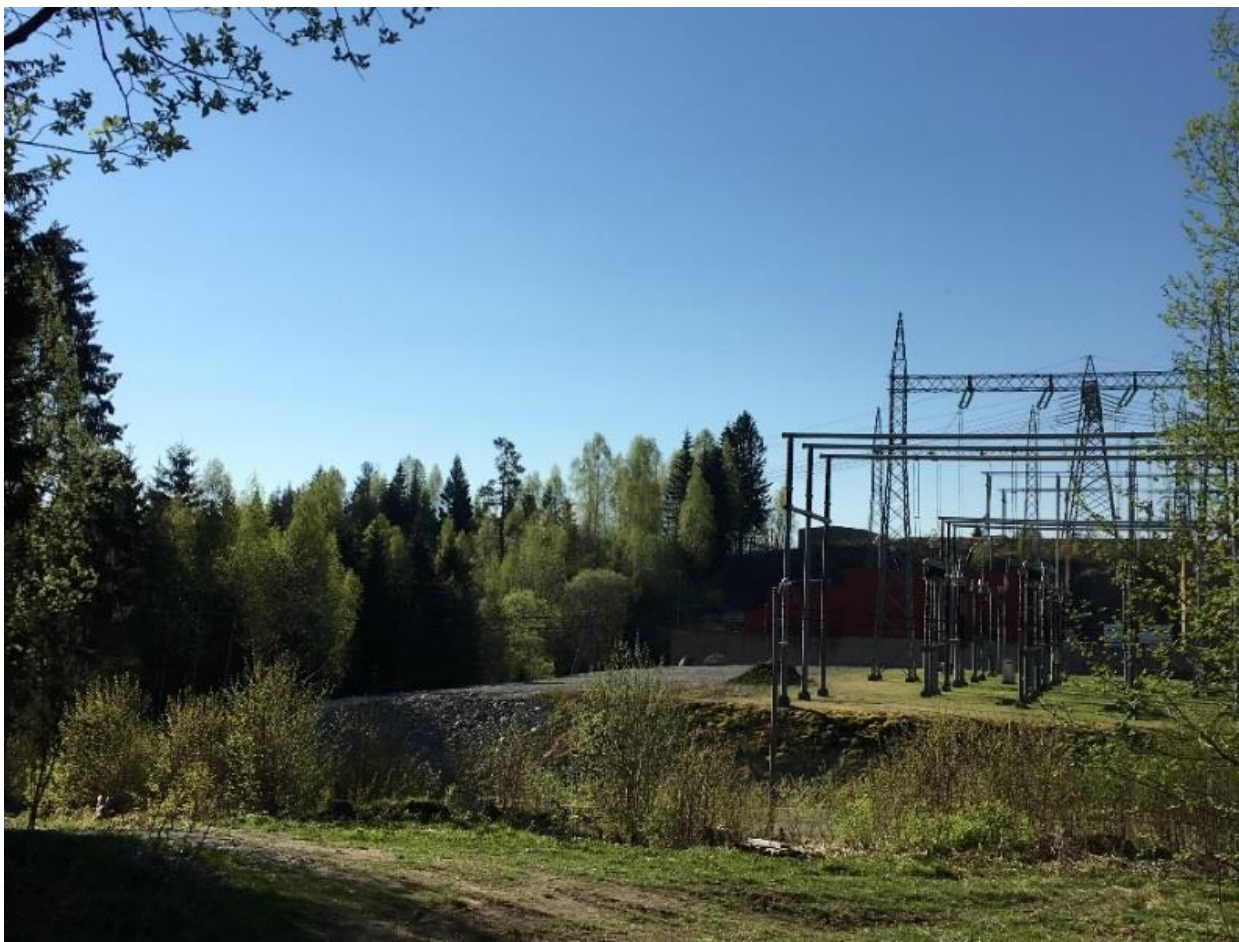
Figur 5: Tomt for nytt kontrollbygg sett fra nord. Bygget plasseres i skjæring i ryggen omtrent midt på bildet, og får mønehøyde som er noe lavere enn selve ryggen.
