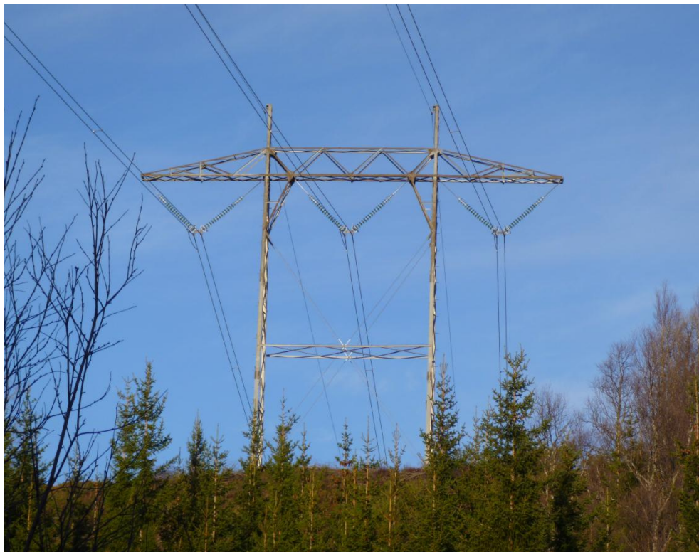
Figur 1. Oppisolering fra 300 til 420 kV ved at isolatorkjedene er forlenget. Øverst del av isolatorkjedene har grå sioaltorskåler, som er for forlengelsen. Opprinnelig isolatorer er grønnfarget. Bildet viser mast med isolatorer i V-form. Endringen vil bli tilsvarende for I-formede isolatorkjeder.
