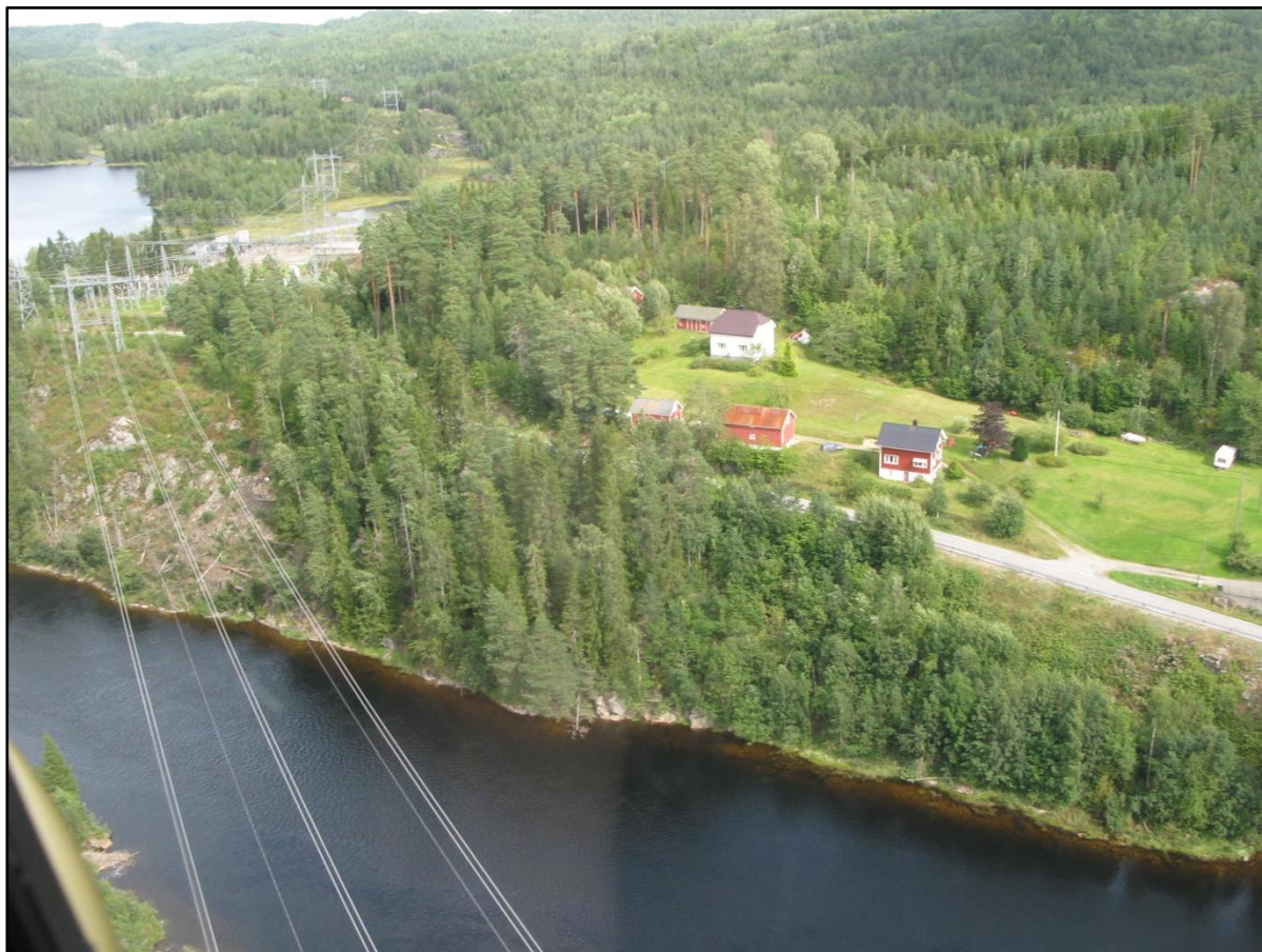
Figur 1. 300 kV-ledningen Kristiansand-Arendal-Porsgrunn forbi Arendal transformatorstasjon. Nidelva i forgrunnen.
