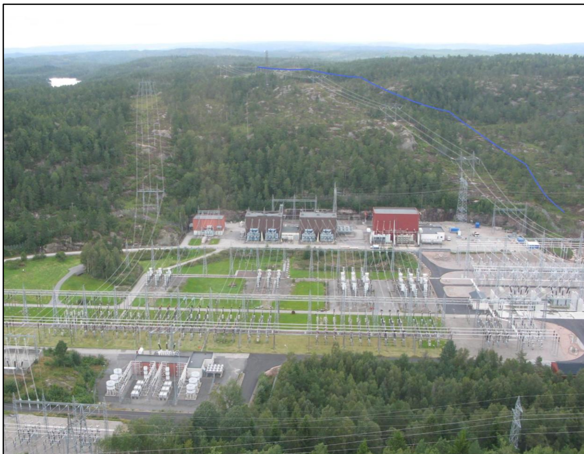
Figur 3. Eksisterende 300 kV-ledning Kristiansand-Arendal (til venstre i bildet) ut fra Kristiansand transformatorstasjon. Ledningen rives fra stasjonen og opp lia til kryssingspunktet med 420 kV-ledningen Kristiansand-Brokke (til høyre i bildet), og erstattes med en ny 420 kV innføring til stasjonen på østsiden av Kristiansand-Brokke. Traséen til den nye forbindelsen er vist med blå strek.
