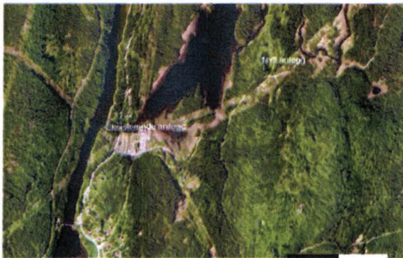
Figur 6: Viser flyfoto av område for eksisterende Arendal transformatorstasjon og planlagt område for nytt anlegg. Kilde: Statnett
