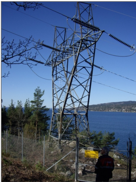
Figur 5: Endemast på Brenntangen sør.
