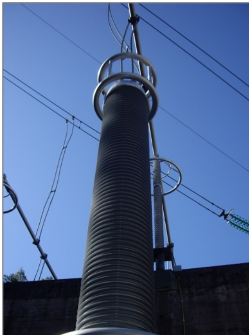
Figur 4: Gassisolert endemuffe for sammenkobling mellom PEX sjøkabel og 420 kV luftledning.
