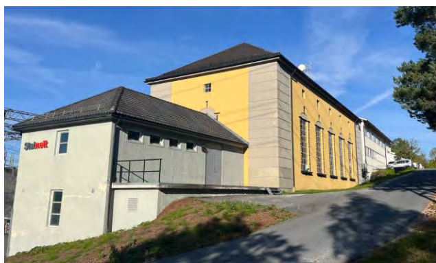
Figur 2-8 Bygningssmasse på Statnetts del av Flesaker transformatorstasjon (Foto: Multiconsult).
