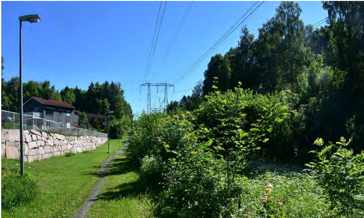
Figur 5-2. Dagens trase like øst for Hamang trafo med bebyggelse, gangvei og hager under gjengroing. Foto: Sweco Norge.
