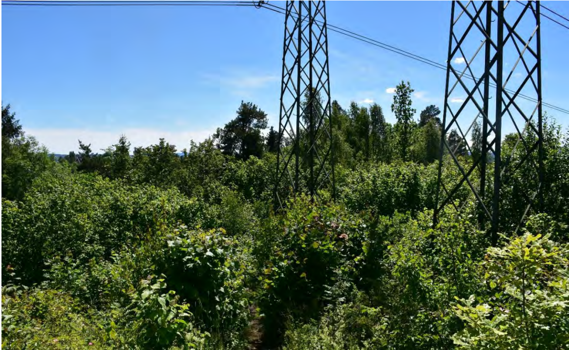
Figur 4-2. Ryddebeltet utgjør ca. 40 m og ryddes jevnlig. I dette området ved Hagabråten er det svært produktivt og ryddebeltet gror raskt ikke. I forkant av bildet passerer en sti. Foto: Sweco Norge.
