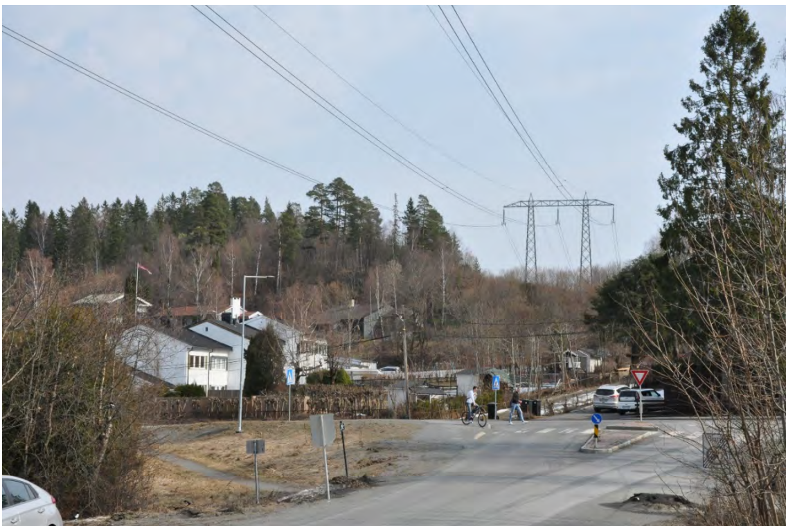
Figur 5-17 Ved Hagabråten ligger traseen diagonalt på de overordnede landskapsformene, noe som skaper en markant silhuettvirkning der anlegget krysser høydedraget. Foto: Sweco Norge AS.
