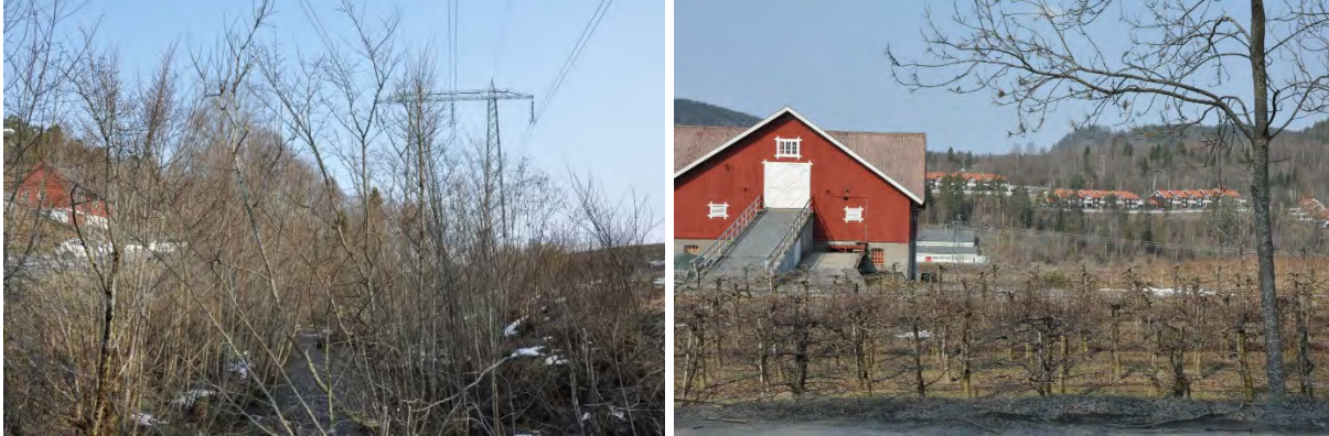
Figur 5-21 Bildene viser Øverlandselva og dagens kraftledningsanlegg (t.v.) og gårdsbruk med Bærum transformatorstasjon i bakgrunnen. Foto: Sweco Norge AS.
