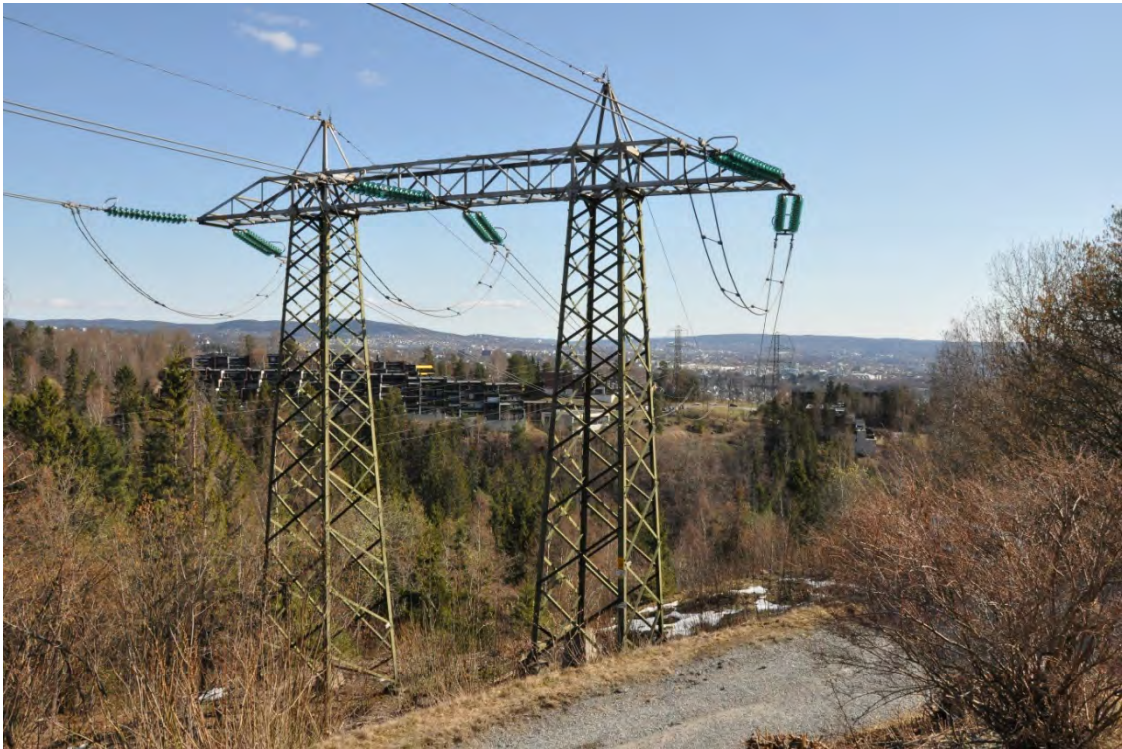
Figur 5-35 Siste mastepunkt før kryssing av Mærradalen, sett fra vest mot øst. Foto: Sweco Norge AS.
