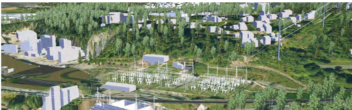
Figur 5-4 Modellbildet viser alternativ med luftledning og nye master i samme utsnitt som over. Kilde: Statnett/ViaNova.
