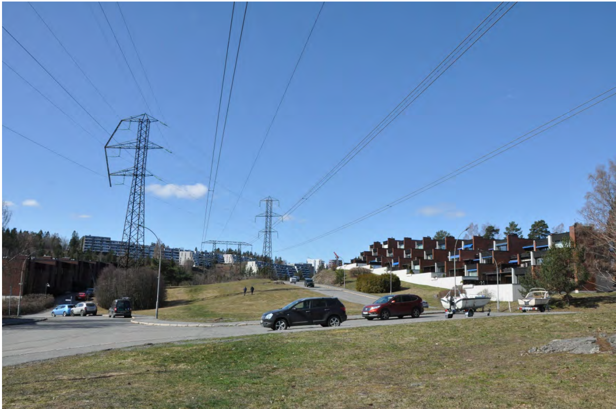
Figur 5-40 Delområdet har preg av to ulike kraftledningsanlegg med forskjellige mastetyper. På grunn av fagverket har de to typene likevel en viss likhet sett i forhold til ny mastetype som introduseres med alternative 1. Foto: Sweco Norge AS.
