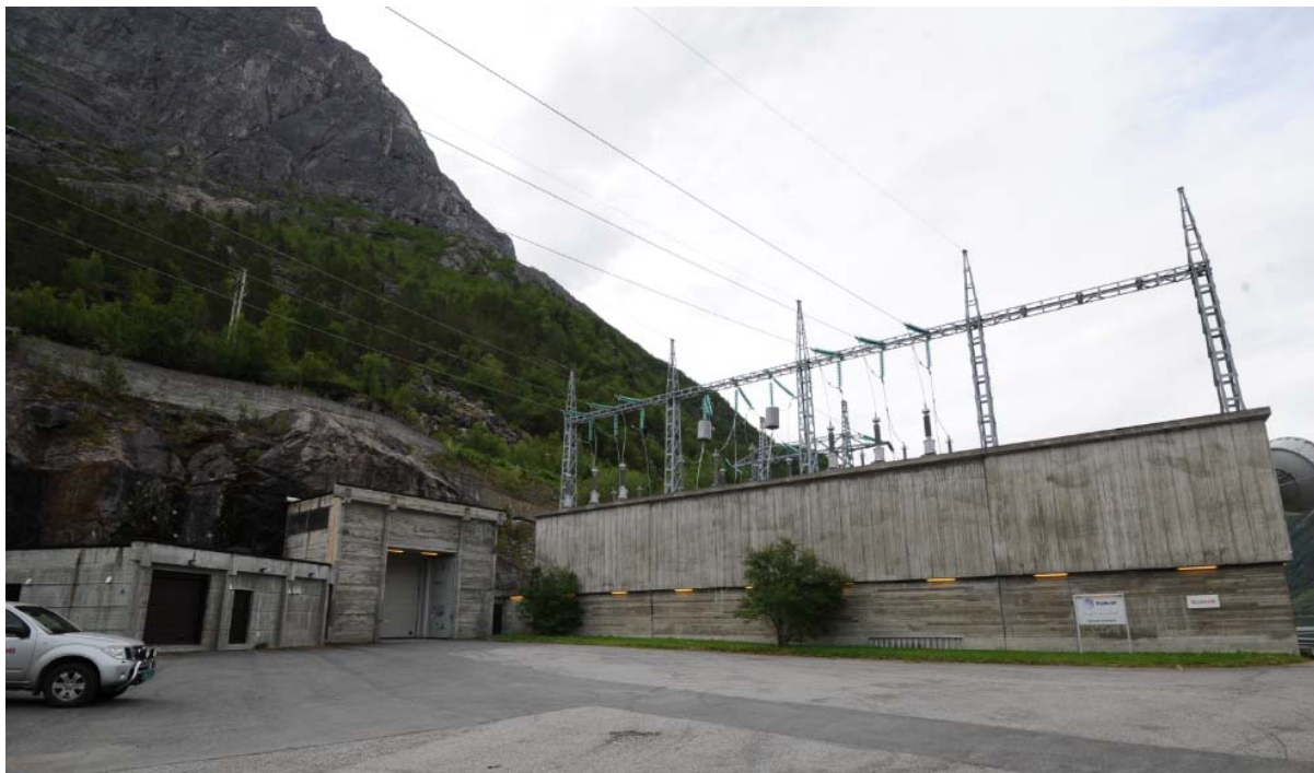
Figur 2. Oversiktsbilde av uteområde for eksisterende stasjon. Bildet viser muffeanlegg til høyre, inngang fjellhall i midten og Statkraft IKT til venstre.
