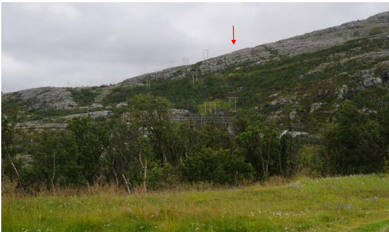
Figur 4-34 Eksisterende ledninger ned mot Lebesby transformatorstasjon sett fra bebyggelsen innerst i vika ved Seivikneset. Løsning 1C vil medføre en ekstra 420kV ledning til høyre for eksisterende ledninger. Nye master får større dimensjoner enn eksisterende master.
