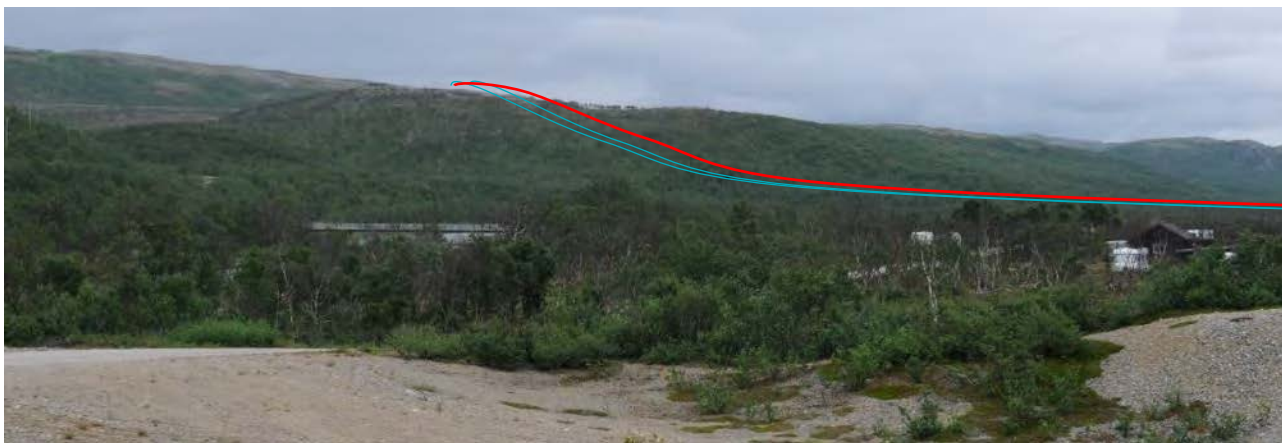
Figur 4-32 Bildet er tatt på Adamssletta vest for brua, som kan skimtes på bildet. Rød strek viser antatt ny 420kv trasé parallelt med to blå for 132kV-ledningene
