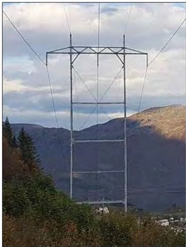
Figur 2-8. Bilder av aktuelle mastetyper, til venstre selvbærende stålmaster (portalmast), høyre: innvendig bardunert mast (M-mast).
