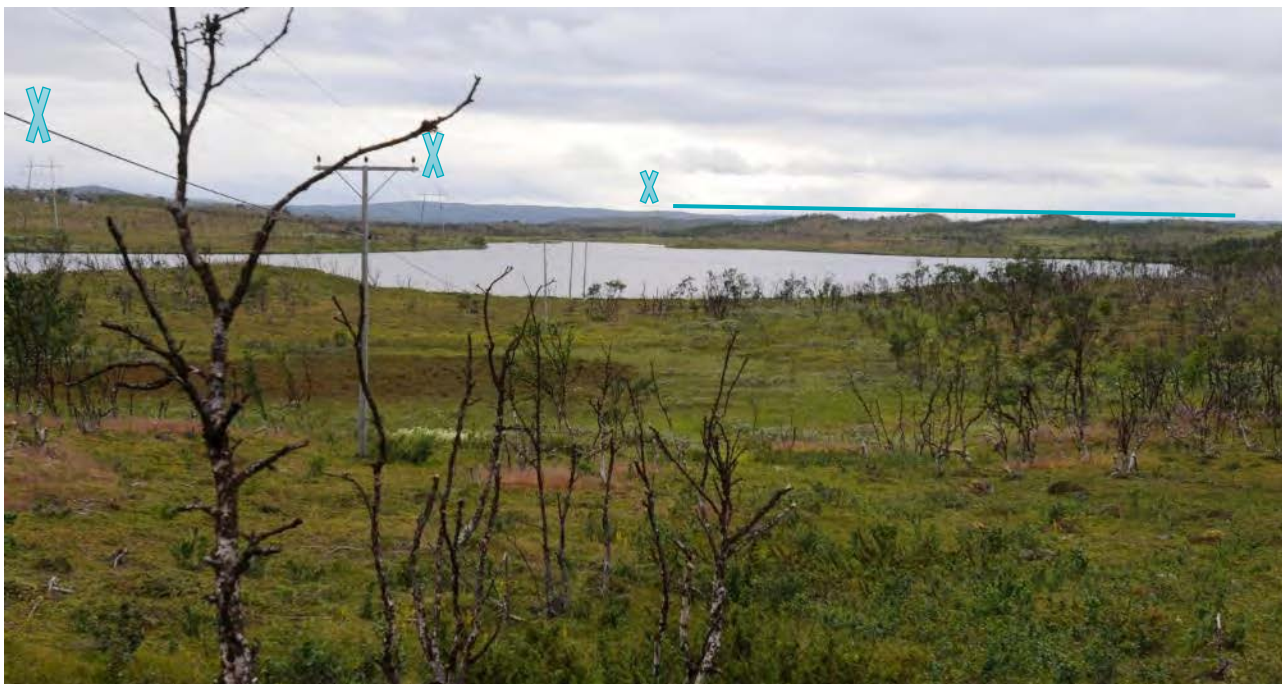
Figur 4-48 Ved alternativ SEI A kan Ivalo-ledningen på sørsiden av Gjeddevatn rives (blå kryss over mastene som vil rives). Den vil legges om nordover inn til stasjonsalternativ SEI A til høyre i bildet (blå strek).
