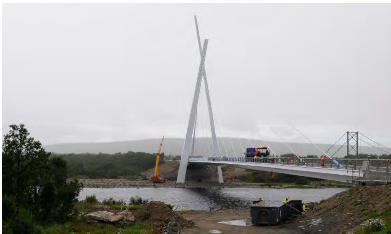
Figur 4-17 Nye Tana bru under bygging sommeren 2020
