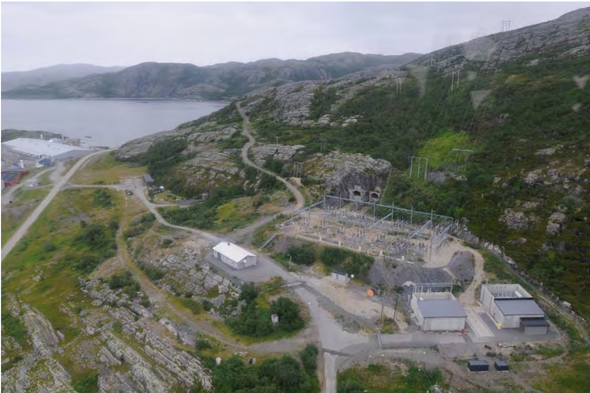
Figur 4-9 Transformatorstasjon og industri ved Seivikneset, innerst i Landersfjorden (en del av Laksefjorden)
