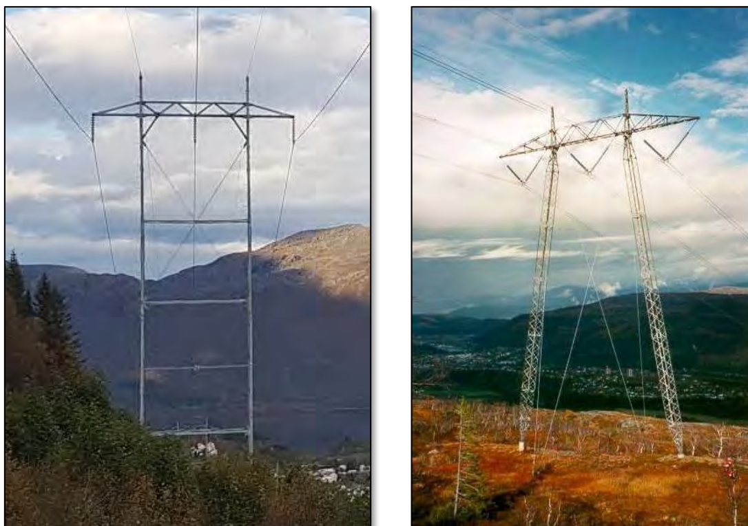
Figur 2-2. Bilder av aktuelle mastetyper, til venstre selvbærende stålmast, til høyre utvendig bardunert mast (M-mast).
