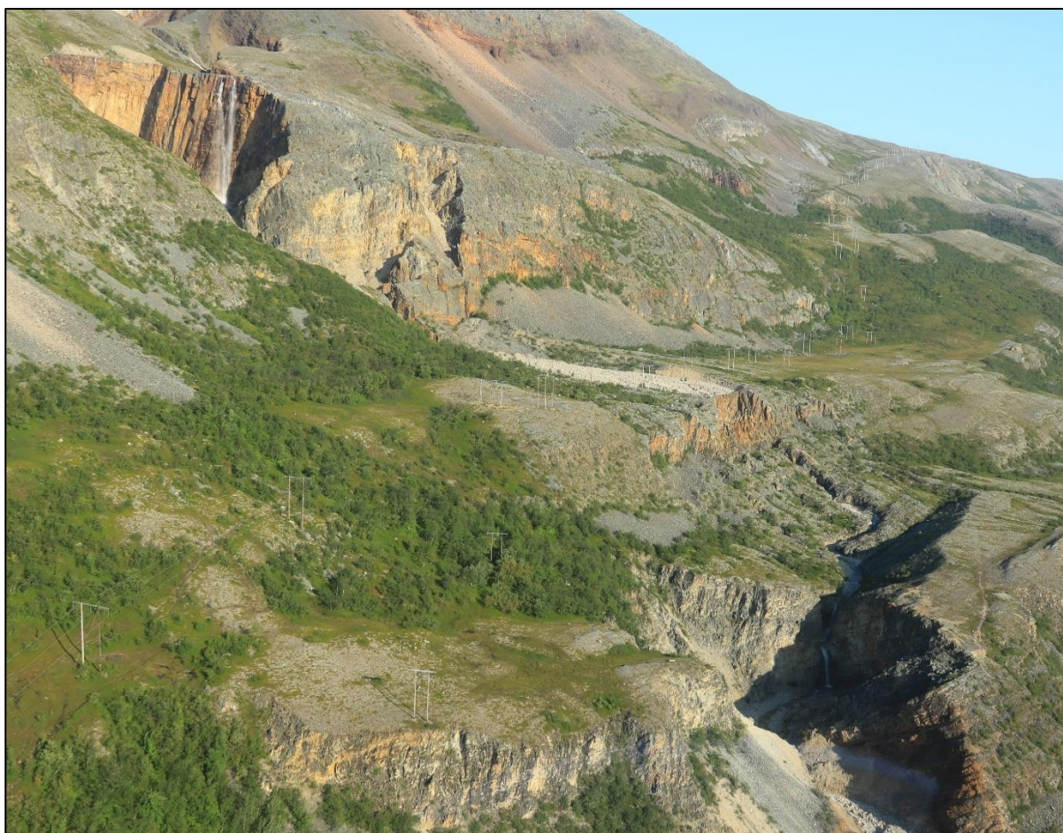
Figur 2-18. Eksisterende 66 kV mellom Stabbursdalen og Lakselv, som kan saneres ved bygging av ny 420 kV, kan sees midt i bildet (går parallelt med eksisterende 132 kV ledning fra Rahppafossen og videre nordover).
