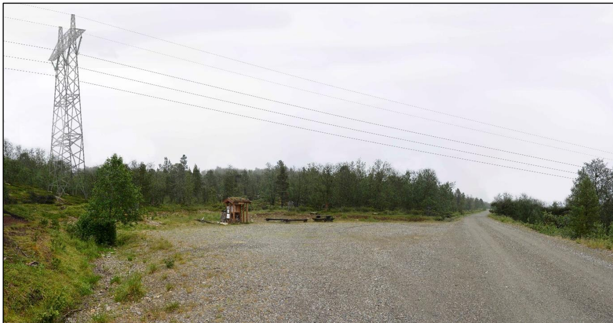
Figur 4-17. Visualisering av ledning (alt. 1.05) fra veien som går innover Brennelvdalen hvor det er plassert bålplasser og infoskilt.
