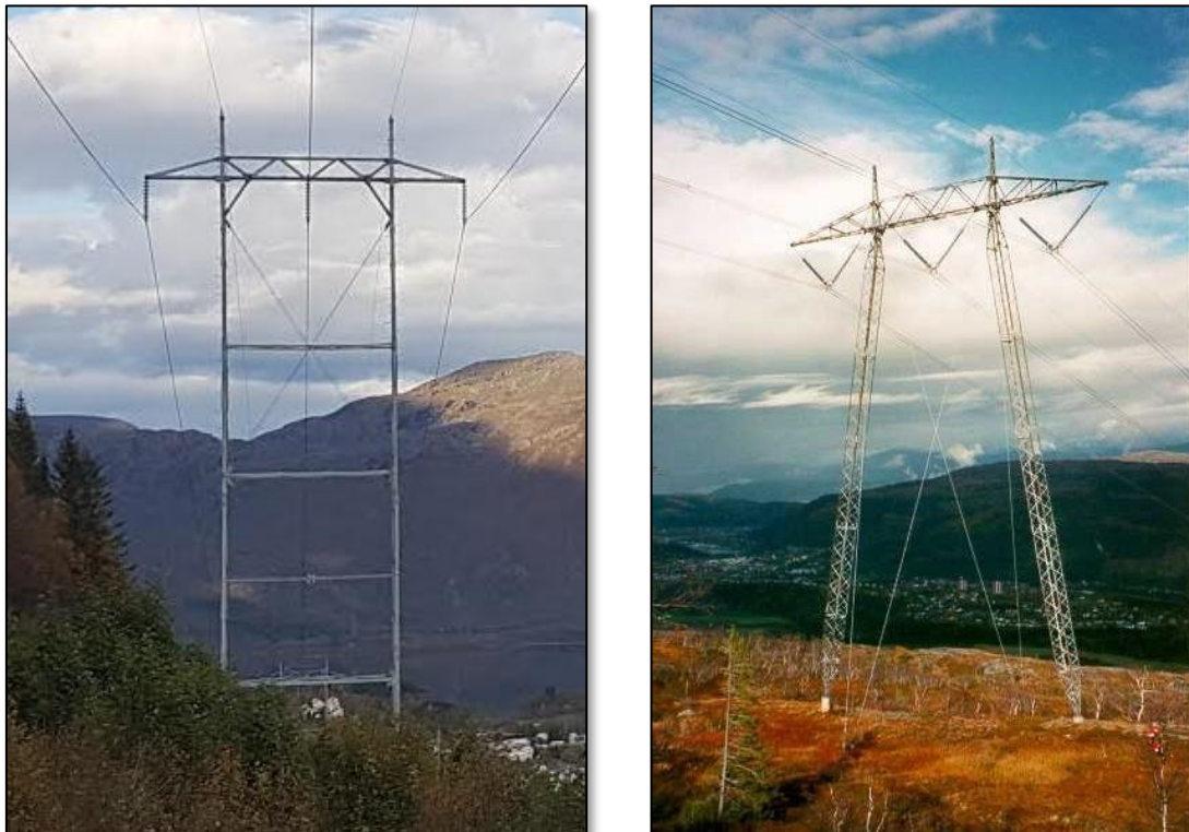
Figur 2-2. Bilder av aktuelle mastetyper, til venstre selvbærende stålmas, til høyre utvendig bardunert mast (M-mast).
