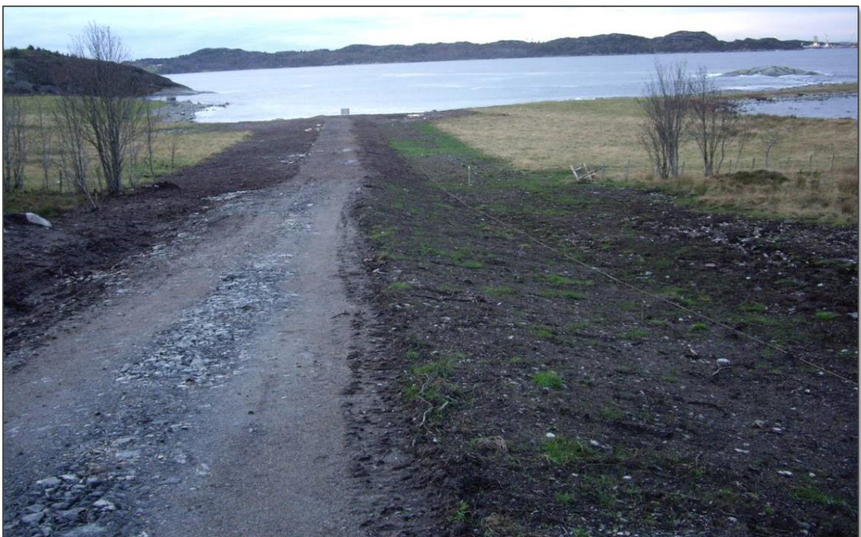
Figur 2-4. Jordkabelanlegg etter at kabelgrøft er gjenfylt og terreng reetablert. Foto: Statnett.
