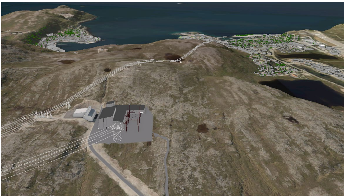
Figur 2. Illustrasjon av ny 420 kV GIS stasjon på Hyggevatn. Hammerfest energi sitt 132 kV GIS anlegg vises til venstre i illustrasjonen.
