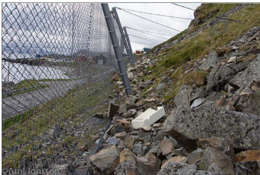
Figur 5. Eksempel på 4 m høyt steinspranggjærde som også viser netting, stolper og barduner.
