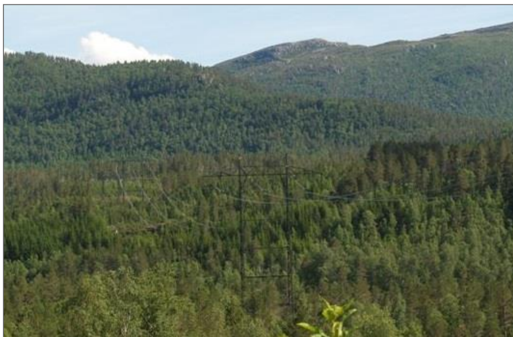
Figur 17: Bilde av kamuflert kraftledning. Her er mastene malt mørk olivengrønn for å etterligne skyggene i terrenget. Linene er mattet, og isolatorene er av kompositt i stedet for av glass som er vanligst å benytte.
