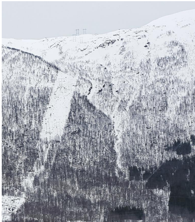
Bilde 1 Parallelførte ledninger fra Standvatnet mot Sauen (Evenes kommune). Effekten av ulik hogst på landskapet lags traséen. Foto Statnett.
