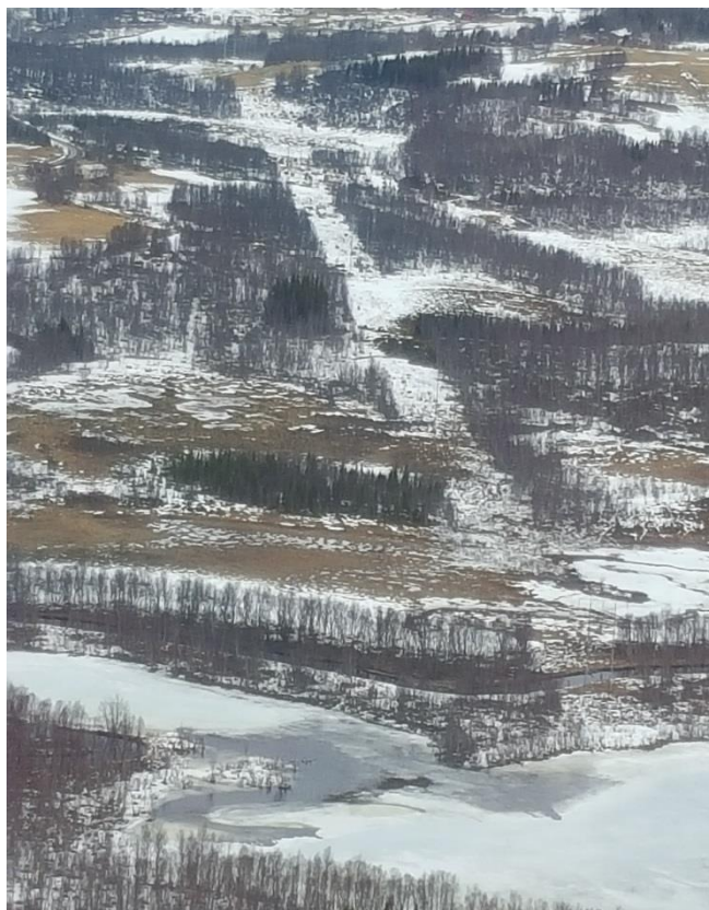
Bilde 3 Dagens trasé går gjennom to naturreservater, hhv Myrvatnet NR i Troms og Sommervatnet NR i Nordland. Foto: Statnett.
