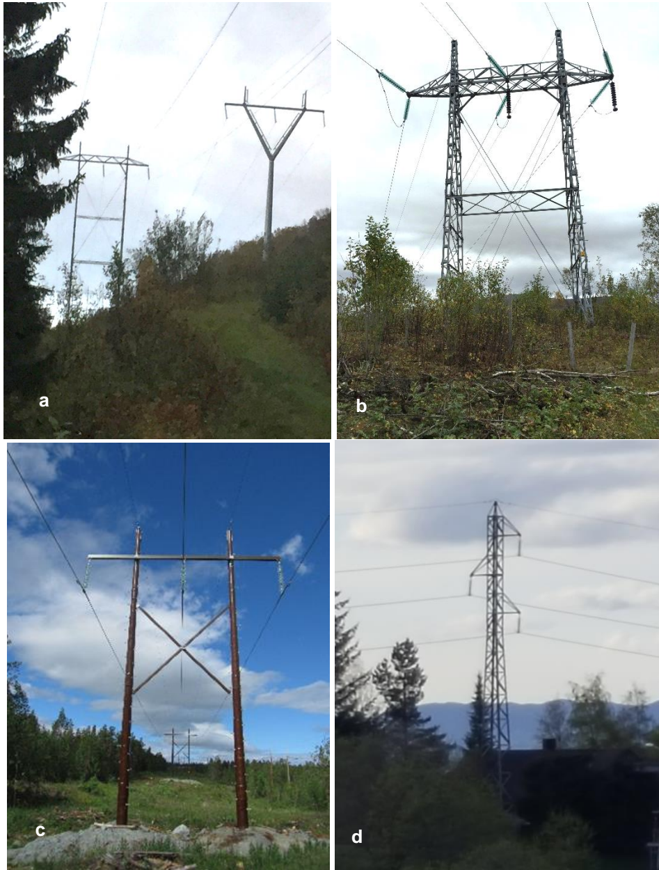
Bilde 2. a) Rasmast ved Bogen til høyre, selvbærende standard portalmas venstre. Begge er 132 kV. b) En typisk forankringsmast, 132 kV. c) 132 kV komposittmast med ståltravers. d) Enkeltfaset mast med trekantoppheng (denne er 66 kV). Foto: Statnett.
