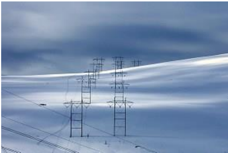
Bilde 4 Parallele traséer oppfattes gjerne som mest ryddige når man har samme mastetype. Her er 132 kV ledningene mellom Kvandal – Kanstadbotn og Kvandal – Kvitnes. Foto: Statnett.
