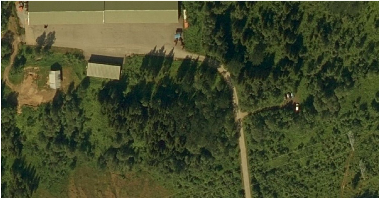
Figur 3: Parkeringsplassen vises til høyre i bildet. Selve stasjonsbygningen vil plasseres til venstre for veien i svingen inn mot eksisterende plass.
