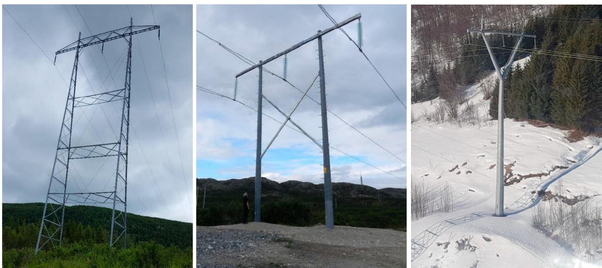
Figur 7: Standard portalmast i stål til venstre, komposittmast i midten og rasmast til høyre.
