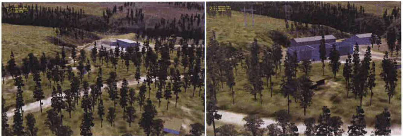
Figur 13. Eksisterende (t.v.) og planlagt (t.h.) Skaidi transformatorstasjon, sett fra fritidsbebyggelse nord for stasjonsområdet.
