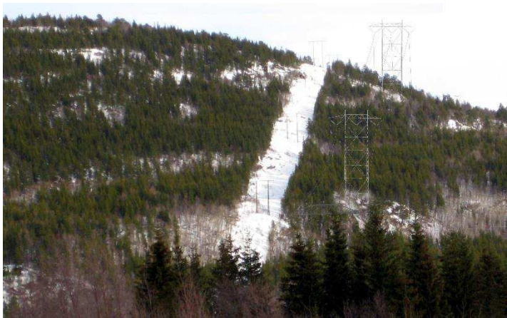
Figur 7. Eksisterende 132 kV kraftledning (t.v.) og konsesjonssøkt trasé (t.h.) gjennom Lullefjellet naturreservat. Fotomontasjen er hentet fra tilleggsutredning datert mai 2011.
