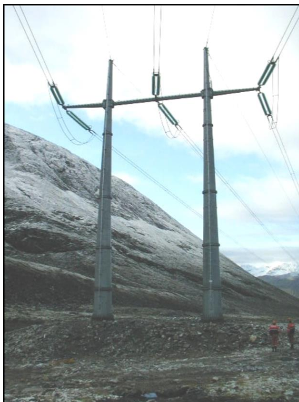
Figur 5. 420 kV skredmast. Mastetypen er konstruert for bruk i skredfarlige områder. Videre arbeid vil avklare om det er strekninger hvor denne mastetypen må benyttes.
