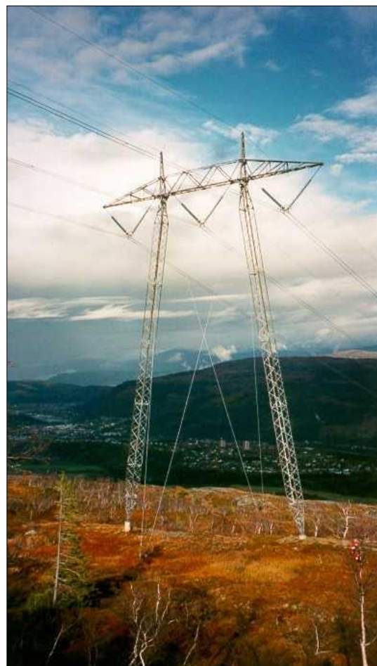
Figur 7. Omsøkt 420 kV mastetype (innvendig bardunert) til venstre. Vurdert mastetype (utvendig bardunert) til høyre.
