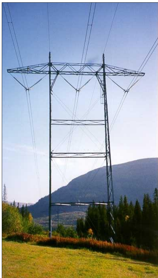
Figur 7. Omsøkt 420 kV mastetype (innvendig bardunert) til venstre. Vurdert mastetype (utvendig bardunert) til høyre.
