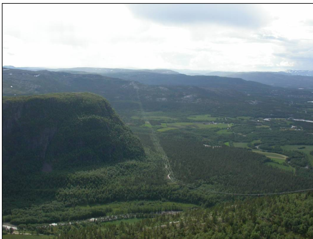
Figur 5.39 Dagens 132 KV som krysser nedre deler av Tverrelvdalen i bakgrunn og nedre deler av Transfarelvdalen. Foto: Anders Mæland.
