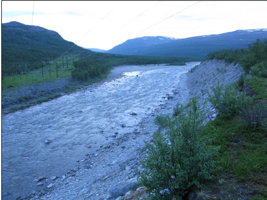
Figur 5.43. Dagens kryssing av elveterrasene ved Repparfjordelva. Foto. Rune Solvang.
